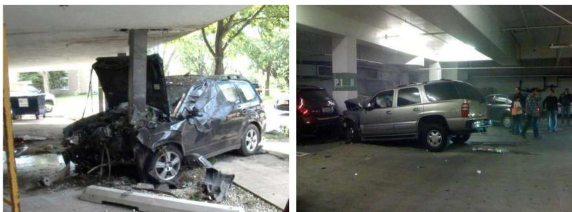
(a) Pilar de edificação danificado pelo impacto de um carro em Chicago, USA (b) Pilar de estacionamento impactado por carro SUV
