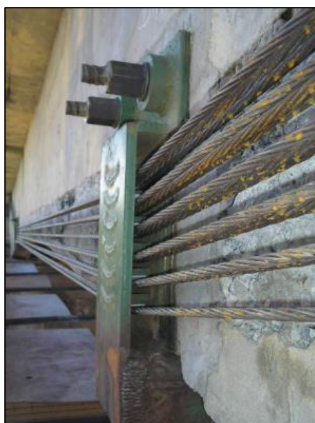
Figura 2.17 – Protensão externa como reforço de ponte.
