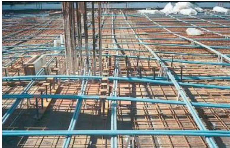
Figura 2.20 - Montagem de laje lisa protendida.
