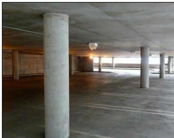
Figura 2.15 – Exemplo de laje lisa protendida.
