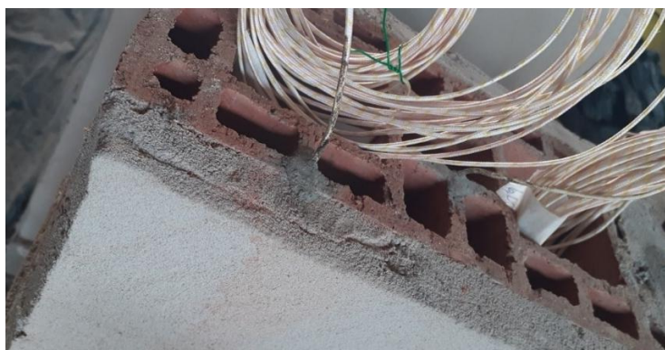
Figura 35: Detalhamento do termopar instalado na parte superior da pequena parede revestida.
