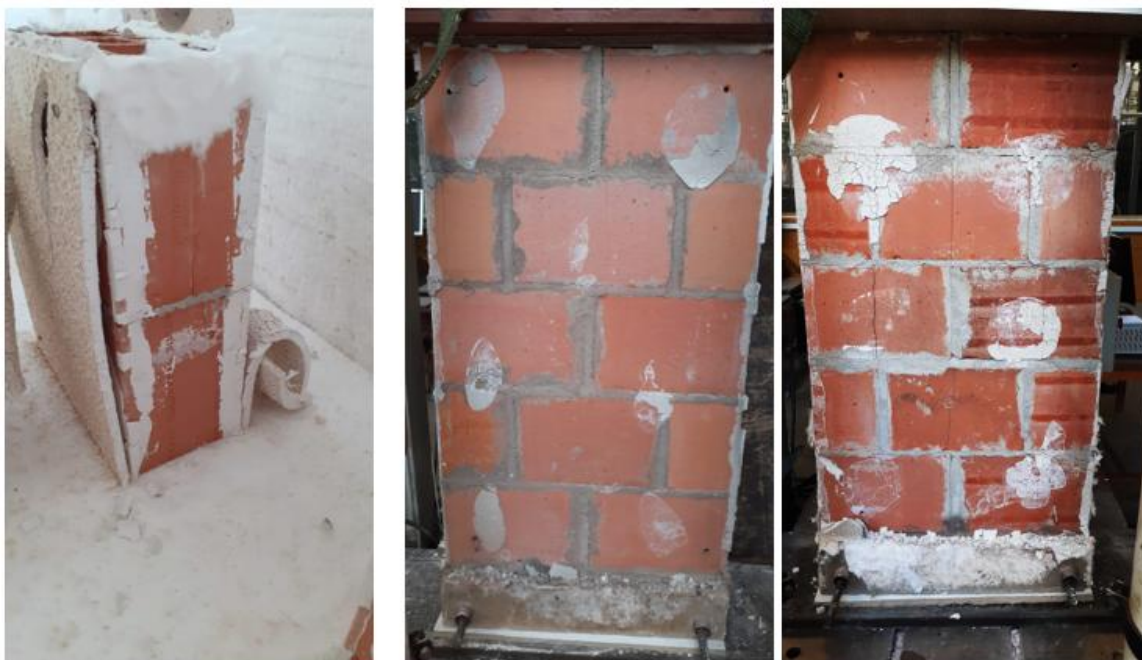
Figura 44: CONJUNTO COM DRAWALL RESISTENTE AO FOGO: 1° - Prisma depois de resfriado. 2° - Parede ao ser retirada do forno, depois do resfriamento. 3°- Parede depois de rompida para verificação da resistência residual
