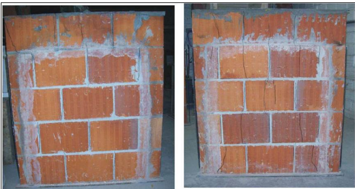
Figura 13: Fissuras na face exposta ao fogo, após o ensaio.
