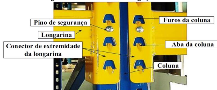
Figura 2-9 – Detalhes das ligações BCC
