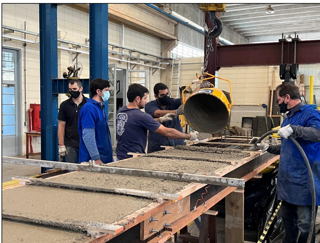
Figura 6.24 – Concretagem do protótipo da laje mista protendida com continuidade
