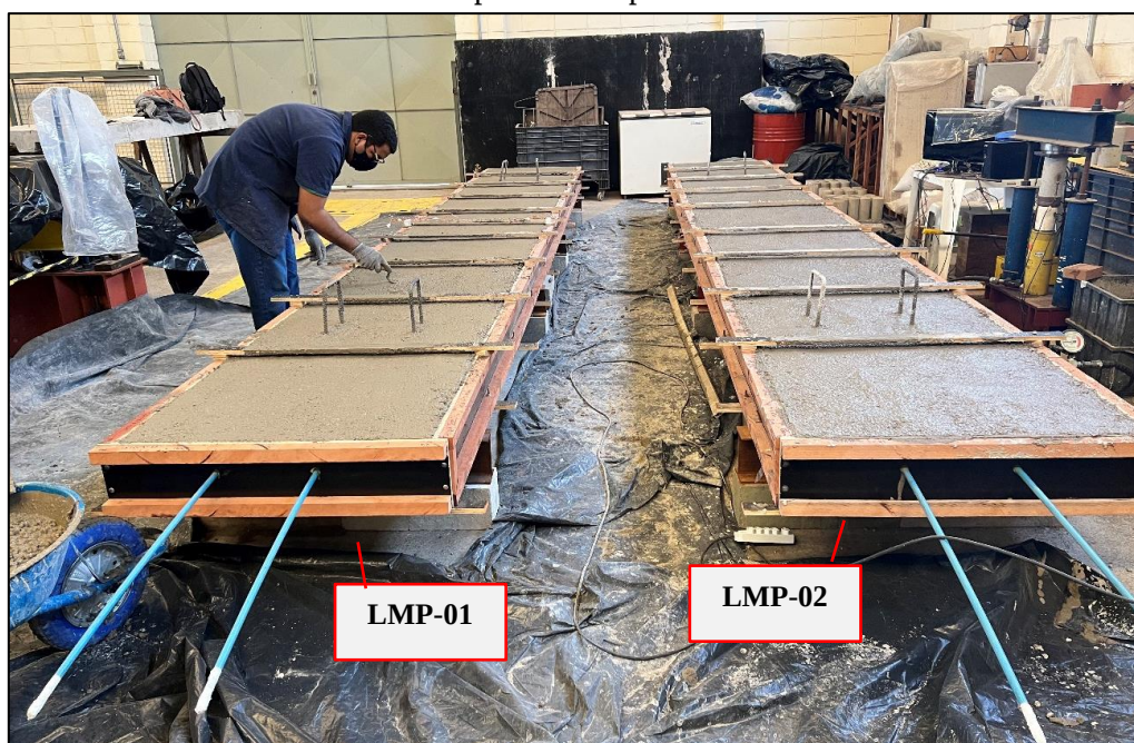
Figura 6.25 – Concretagem e acabamento dos dois protótipos das lajes mistas protendidas simplesmente apoiadas
