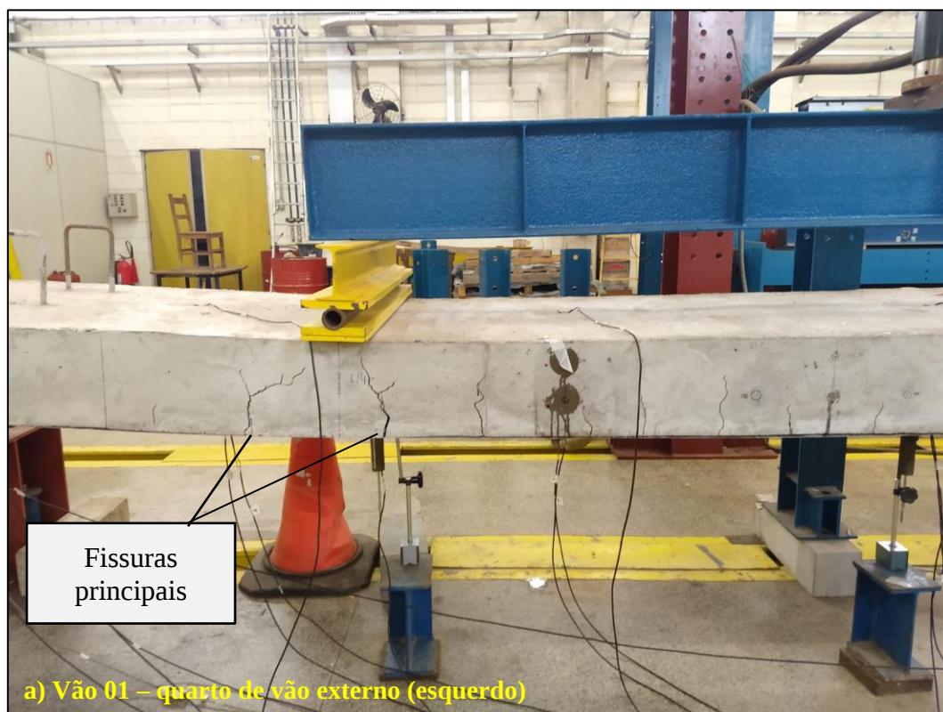
Figura 10.28 - Fissura típica sob ponto de aplicação do carregamento junto ao ponto de carregamento nos quartos de vão externos (vão 01 - esquerda e vão 02 - direita)
