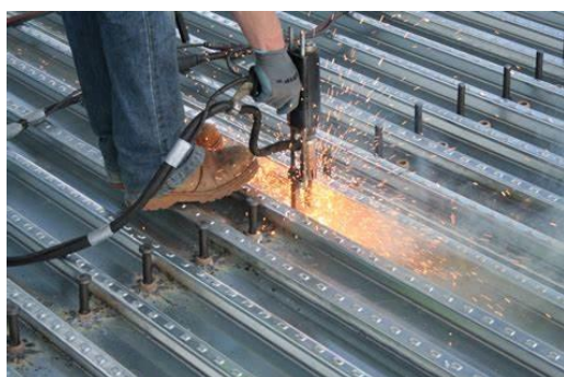
a) Conectores convencional ( stud bolt )
