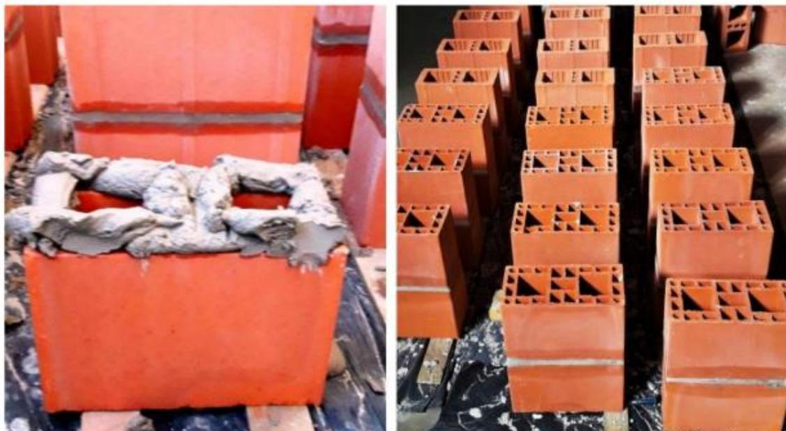
(a) Detalhe da junta de argamassamento total.
