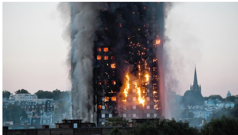
Figura 1 – Incêndio na Torre Grenfell em Londres. As chamas se espalharam rapidamente por conta do revestimento inflamável
