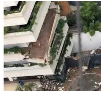
Figura 4 - Desabamento de uma varanda devido à corrosão.
