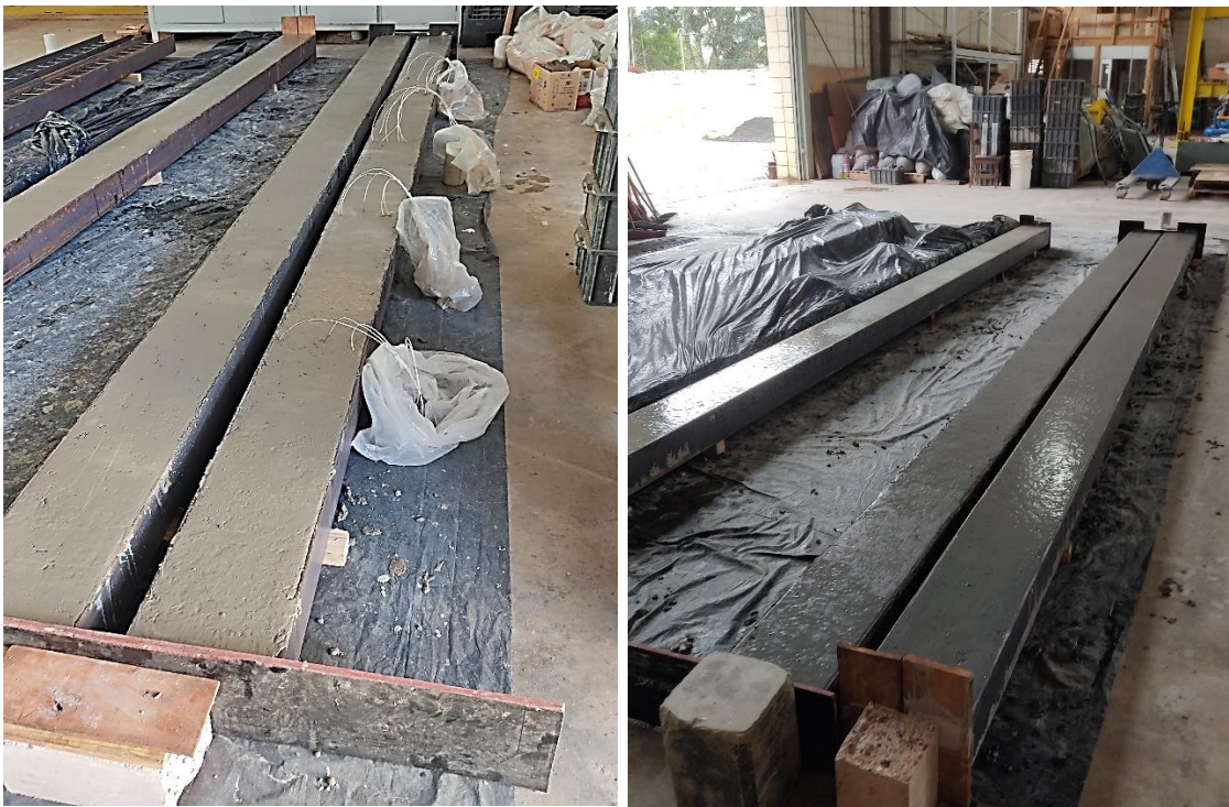
Figura 6.6 – Concretagem das vigas mistas
