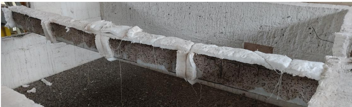
Figura 6.35 - Viga VQ-2 pós-fogo: (a) Lado 1 e (b) Lado 2
