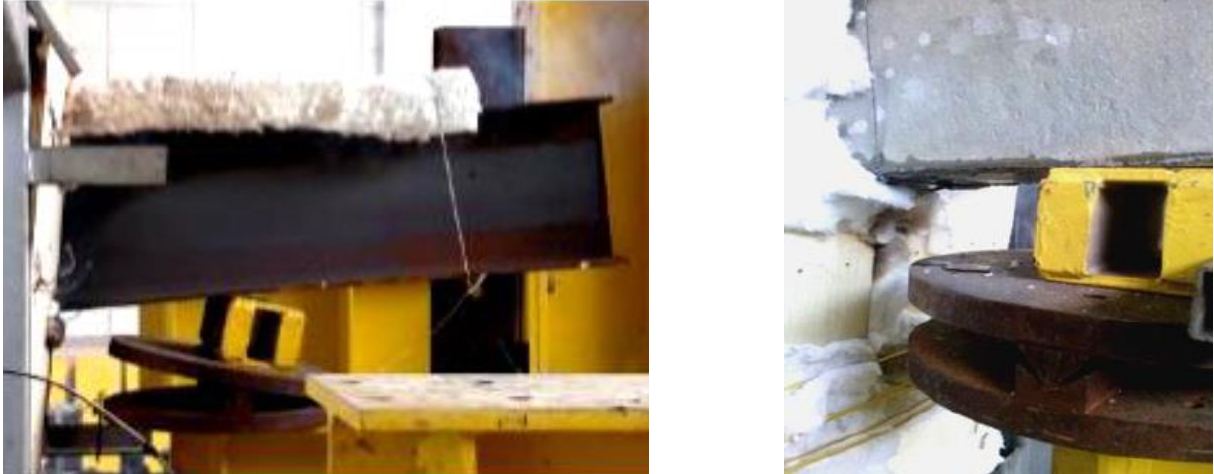
Figura 3.5 - Rotação excessiva nos apoios nos ensaios em incêndio
