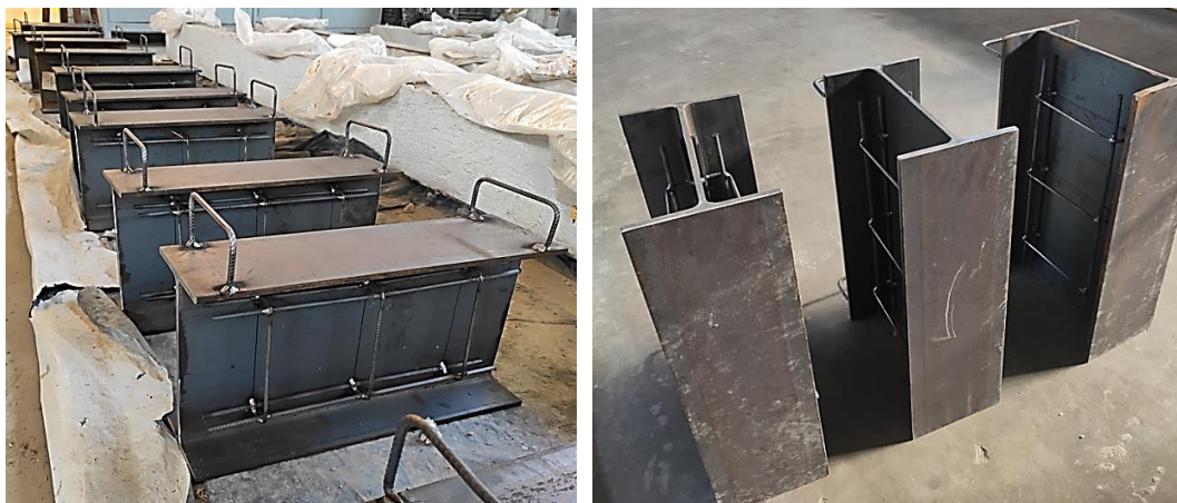
Figura 5.3 – Corpos de prova dos elementos mistos ainda não concretados
