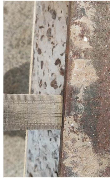
f) Deslocamento lateral VQ-2
