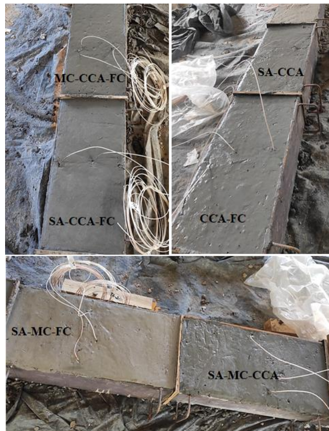
Figura 5.6 – Concretagem para alguns dos elementos mistos do estudo
