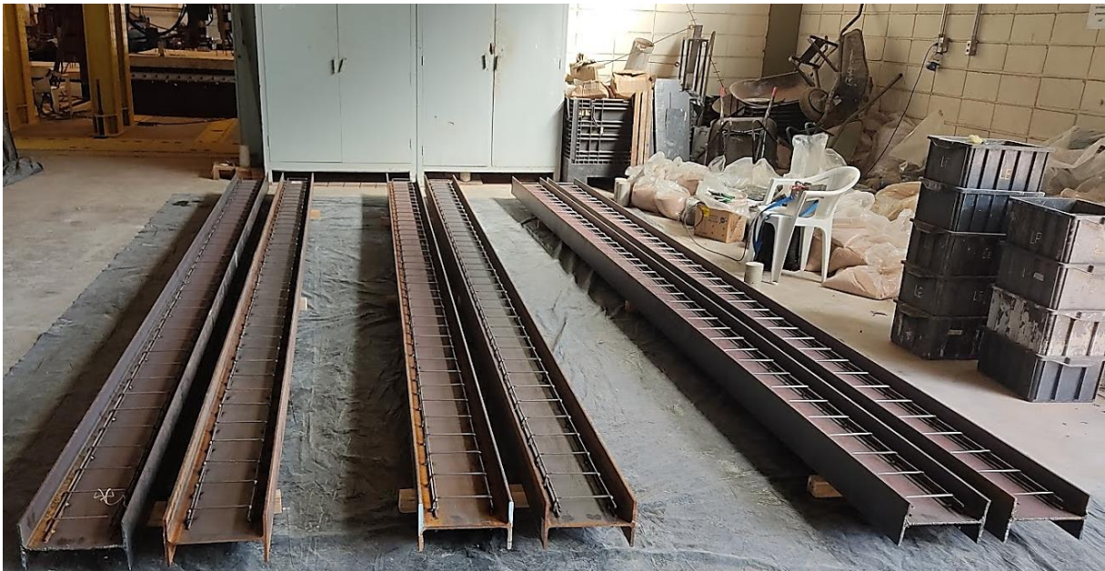
Figura 6.2 – Posicionamento das armaduras no perfil de aço
