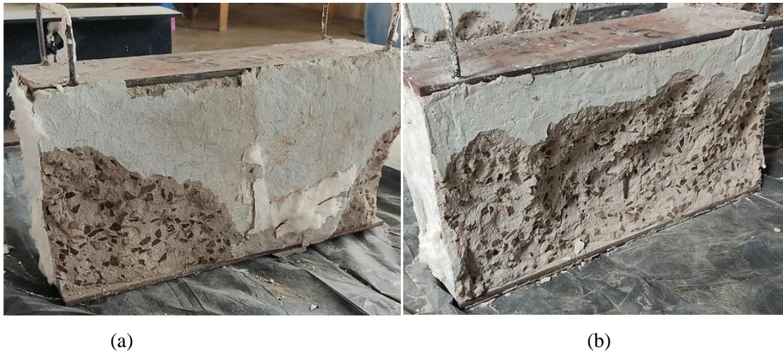
Figura 5.22 - CP2 após exposição ao fogo: (a) lado 1 e (b) lado 2
