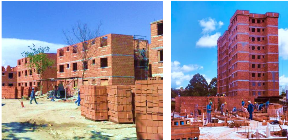
Figura 1.1 – Edifícios em alvenaria estrutural com blocos cerâmicos
