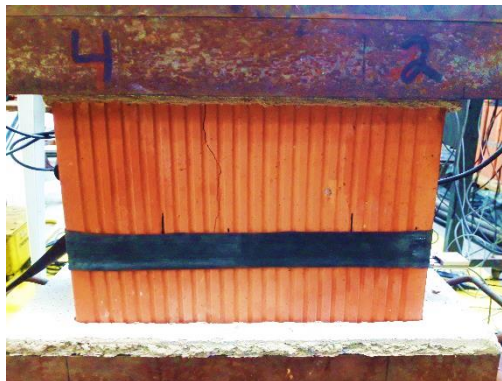
Figura 5.15 – Danos localizados durante os ensaios de acustoelasticidade
