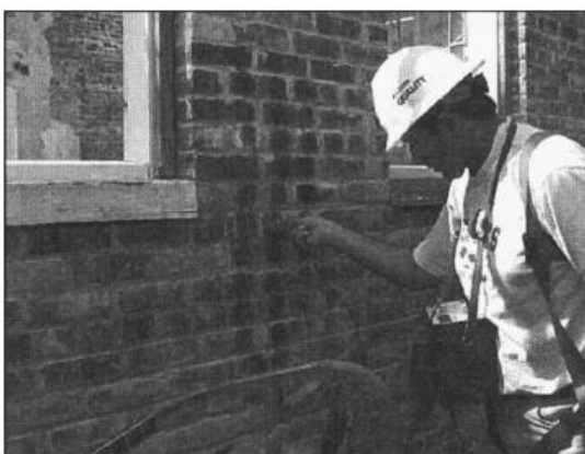
Figura 2.20 – Aplicação do ultrassom em parede de alvenaria
