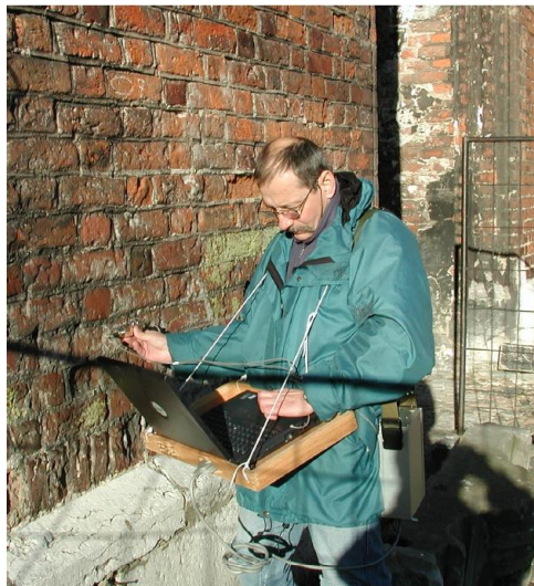
Figura 2.7 – Aplicação do ultrassom em parede de alvenaria
