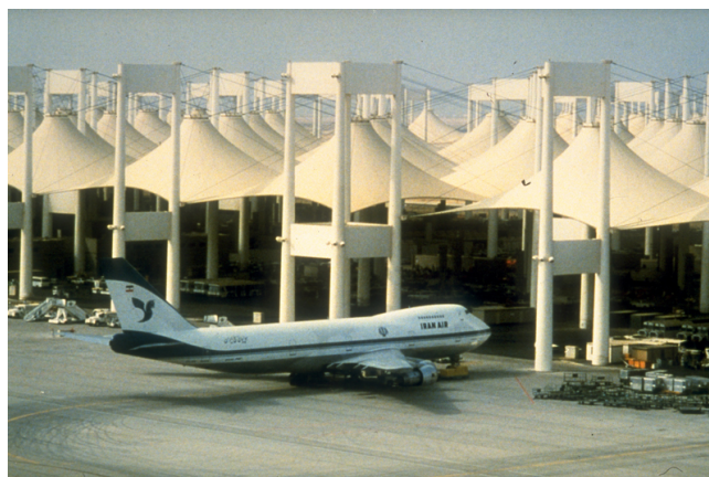
Figura 9 – Terminal Hajj no Aeroporto Internacional Rei Abdullaziz, Jeddah, Arábia Saudita, 1981.
