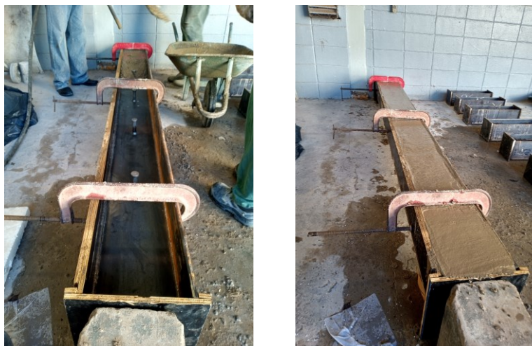
Figura 3.25 – Preparação e concretagem do modelo de VMPR
