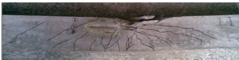
Figura 2.12 – Plano de fissuração de viga ensaiada em Jia et al. (2013)
