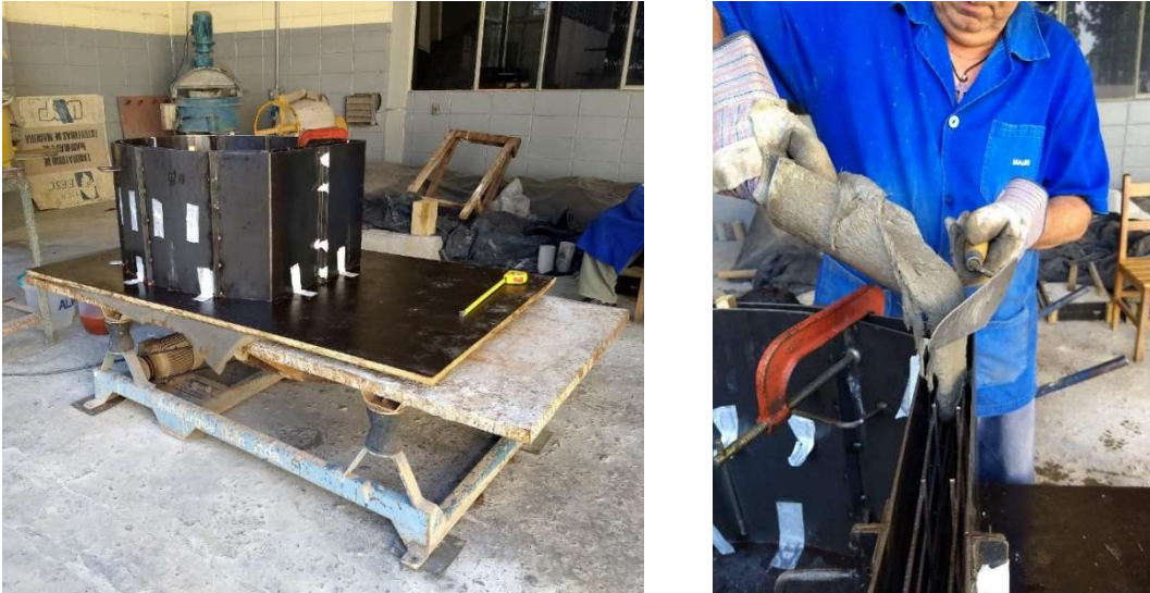
Figura 3.14 Mesa vibratória e processo de concretagem das galerias
