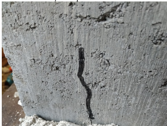
Figura 4.21 – Fissuração no prisma durante ensaio ultrassônico
