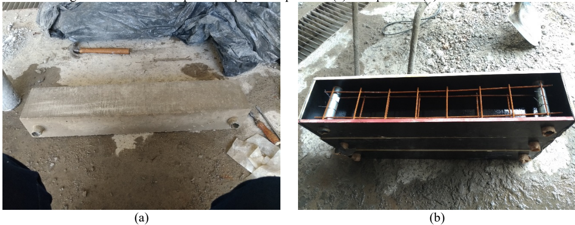
Figura 3.10 – Estrutura para transporte das paredes: (a) base pronta e (b) forma montada
