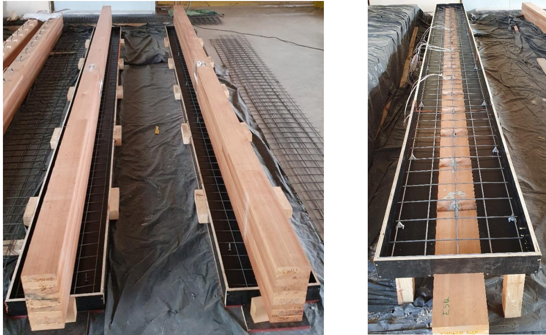
Figura A.9 – Elementos prontos para concretagem
