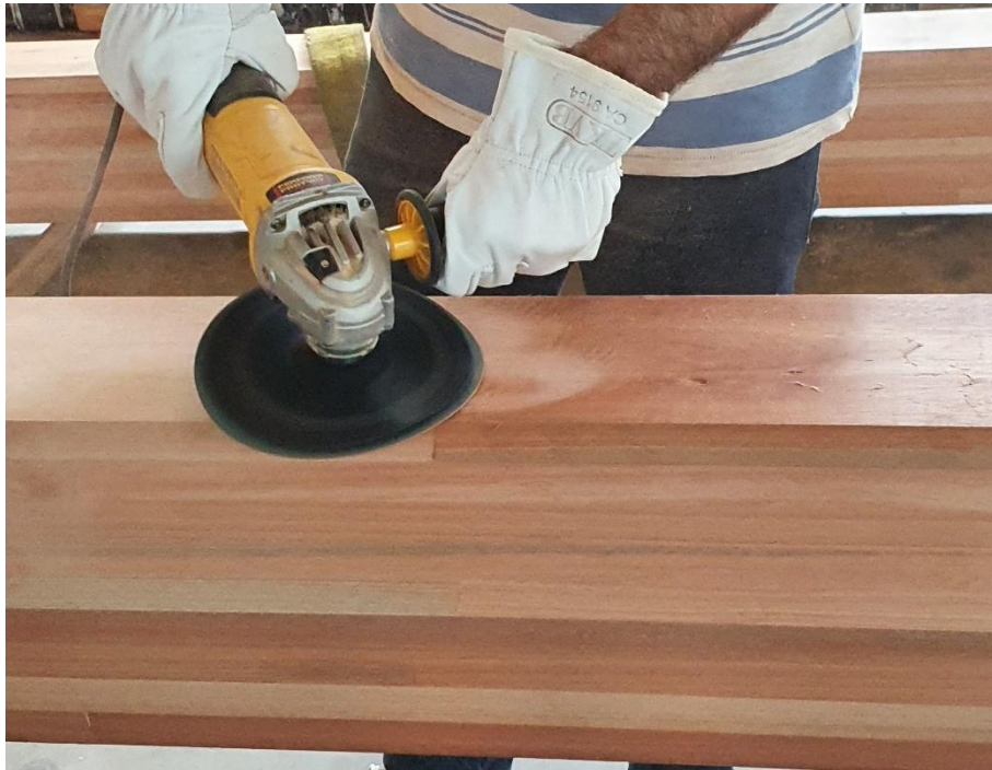
Figura A.12 – Regularização da superfície da madeira.
