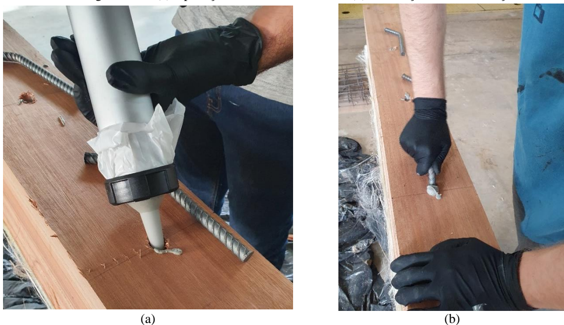
Figura A.8 – (a) Aplicação do adesivo estrutural; (b) Introdução da barra de aço.
