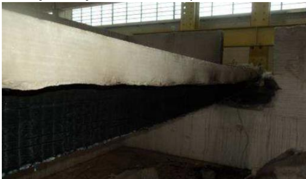
Figura 2.12 – Viga mista de madeira e concreto após 20 minutos de incêndio
