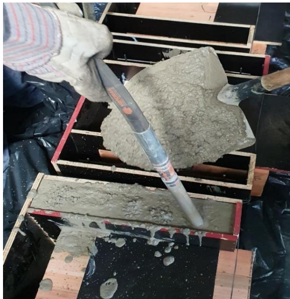
Figura A.5 – Lançamento e adensamento do concreto
