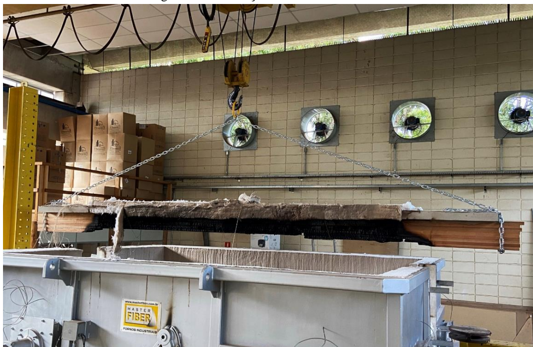
Figura 5.9 – Remoção do elemento estrutural
