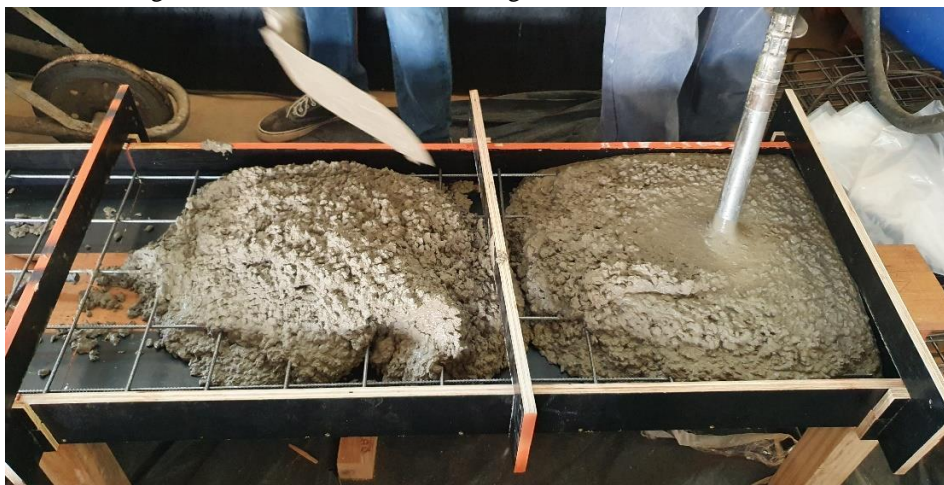
Figura A.10 – Processo de concretagem dos elementos estruturais
