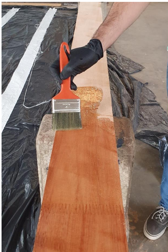
Figura A.13 – Aplicação do Primer
