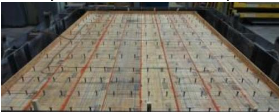
Figura 2.15 – Piso misto de madeira e concreto antes da concretagem
