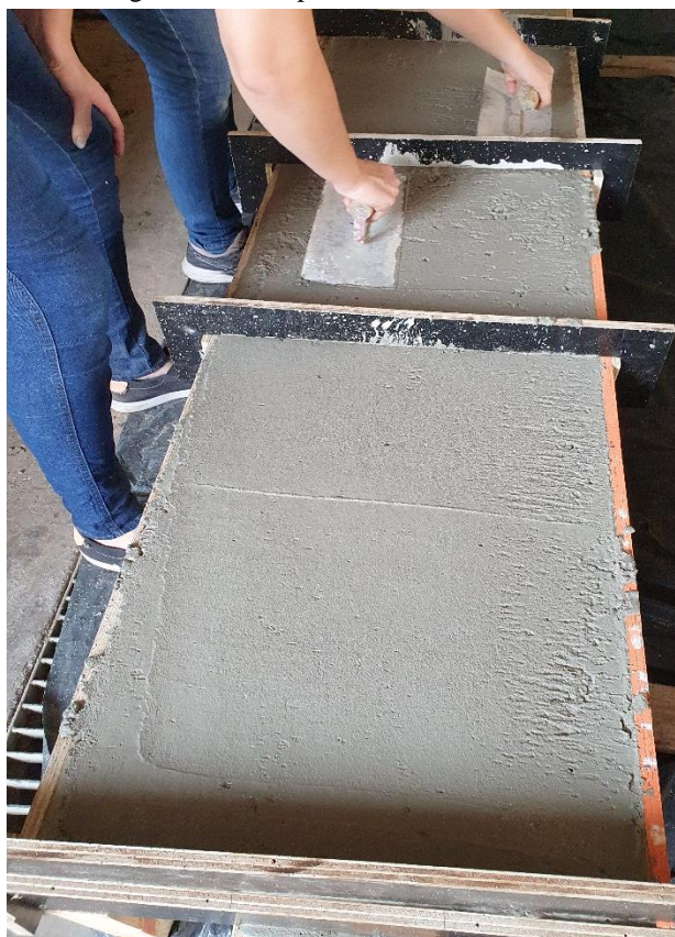
Figura A.11 – Aplainamento do concreto
