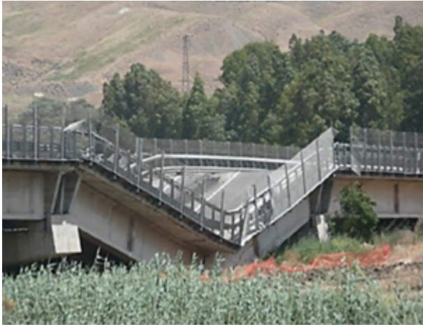
Figura 3.1 – Colapso do viaduto Petrulla , Itália
