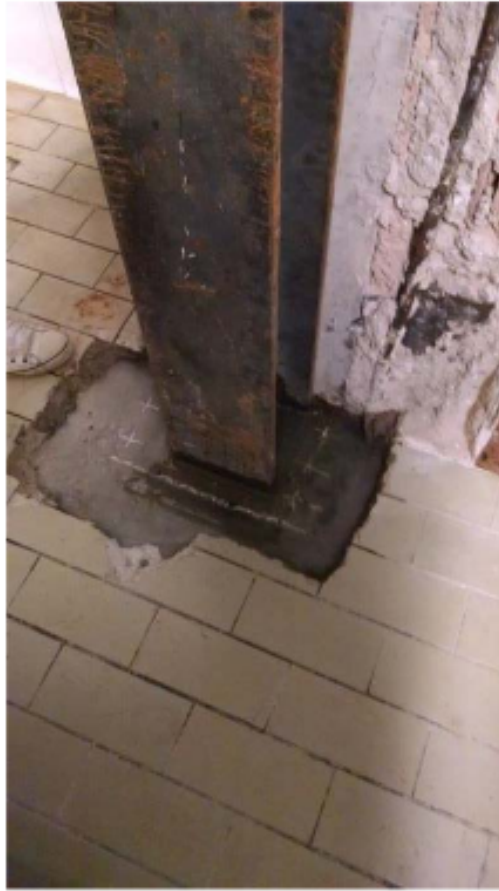
Figura 3 – Exemplo de adição de perfil metálico.
