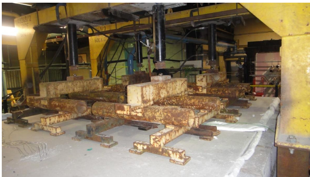
Figura 5.6 - Face não exposta da laje antes do início do ensaio (Protótipo 1)
