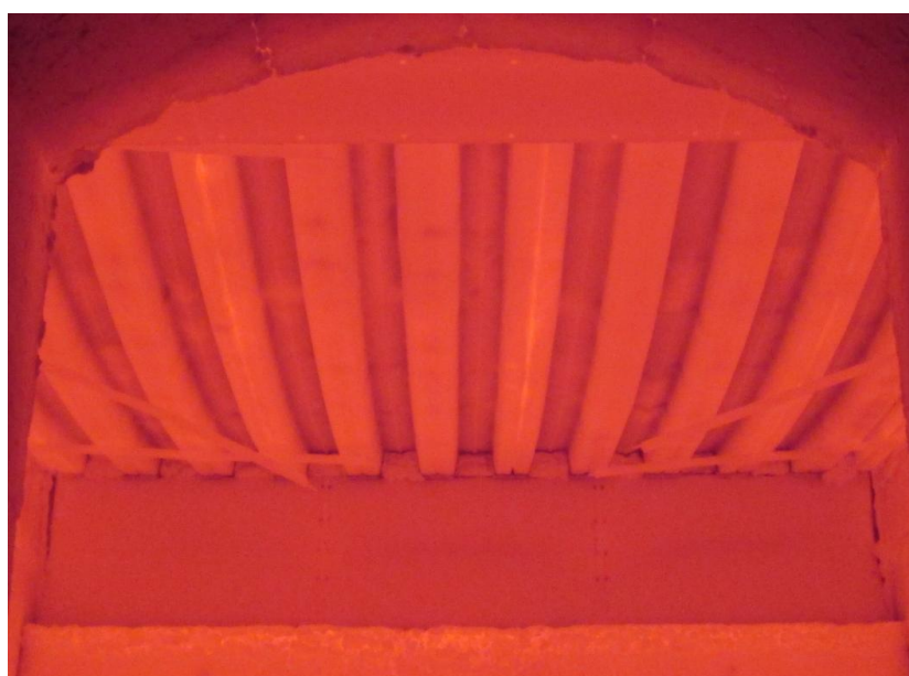
Figura 5.9 - Face exposta da laje logo após a interrupção do ensaio (Protótipo 1)
