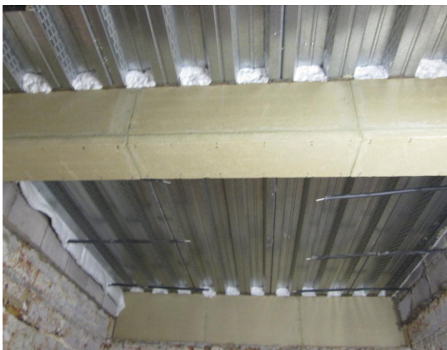
Figura 5.4 - Termopares para a medição da temperatura interna do forno
