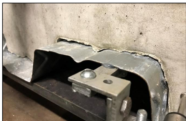
(a) Início do deslizamento
