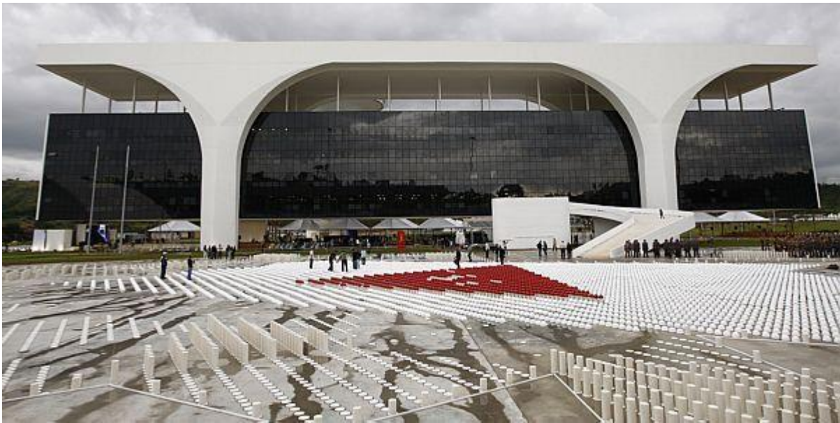
Figura 4 - Cidade Administrativa de Minas Gerais.
