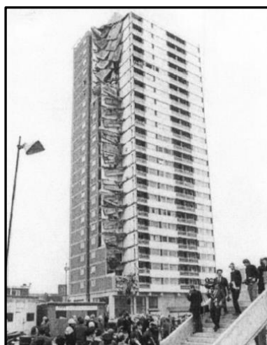
Figura 2.1 – Colapso progressivo do Ronan Point
