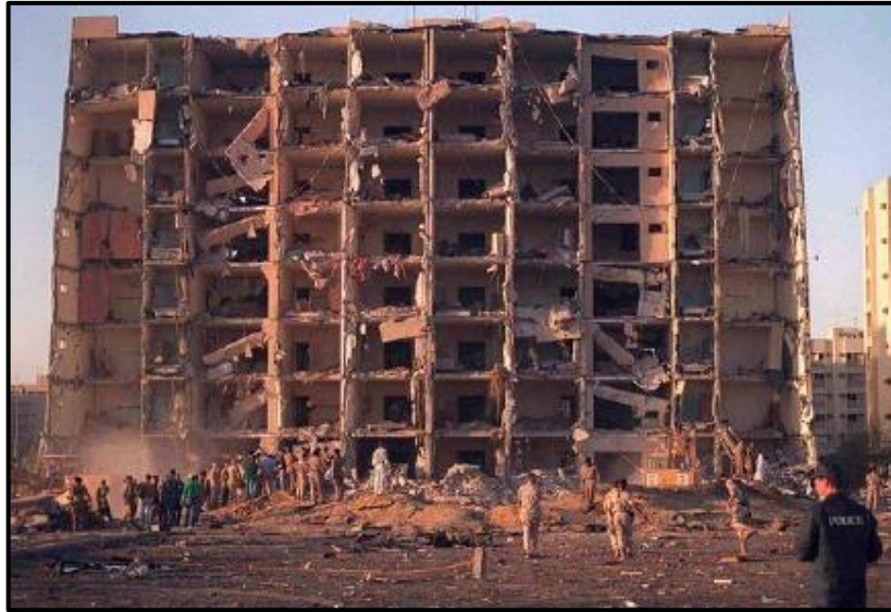
Figura 2.3 – Situação do edifício mais afetado no atentado do complexo Khobar Tower
