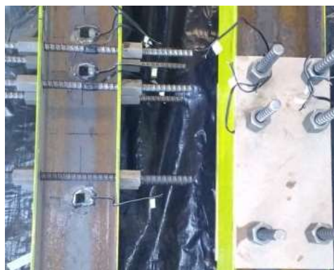
d) Instrumentação antes da concretagem
