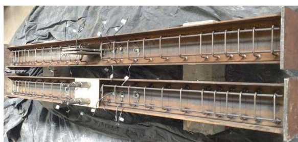
a) Tipologias 1 e 2 antes da concretagem
