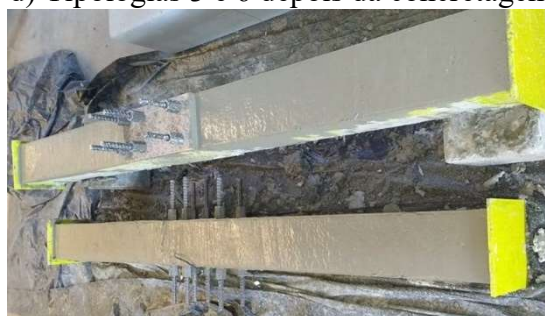
f) Tipologias 4 e 5 depois da concretagem
