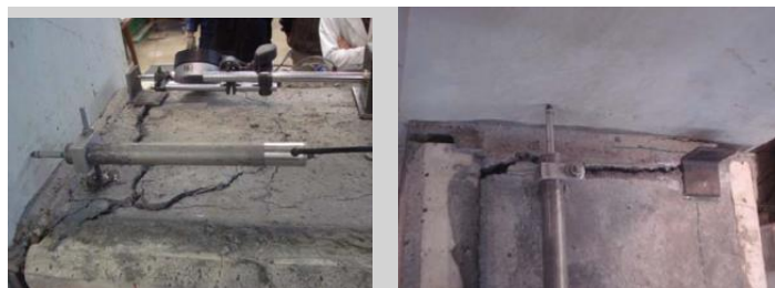
Figura 2.1 - Detalhe da descontinuidade na interface do concreto normal e o UHPC (Fonte: MAYA et al., 2013)
