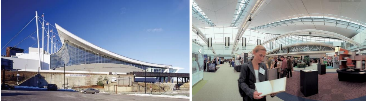
Figura 4 - Vigas pré-tensionadas em cabo: Centro de Convenções David L. Lawrence, Estados Unidos (vista externa e vista interna)
