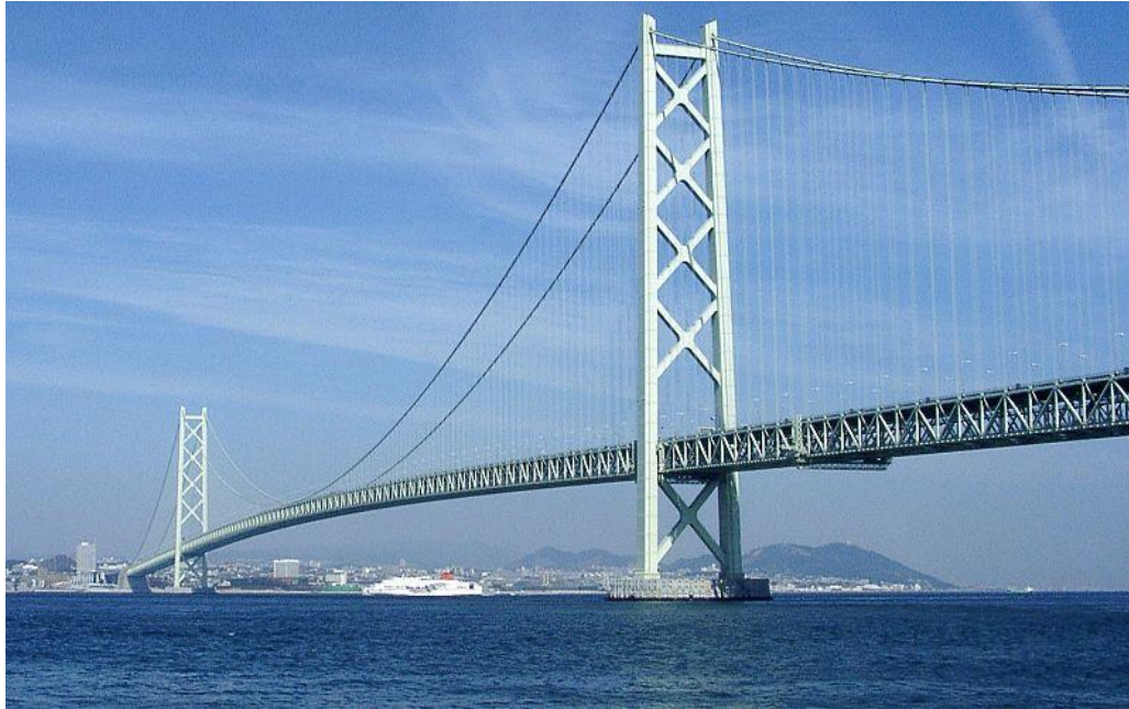
Figura 69 - Ponte Akashi-Kaikyo, Japão
