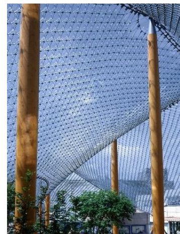
(b) Vista interna
