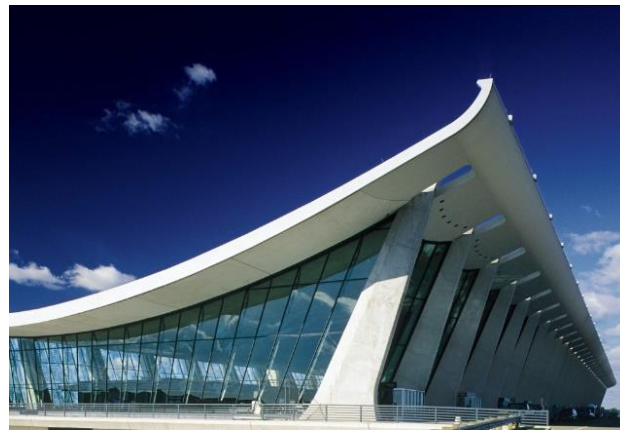
Figura 2 - Cabos simplesmente suspensos: Aeroporto Internacional Washington Dulles, Estados Unidos
