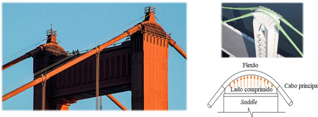
Figura 16 – Detalhes do cabo sobre a saddle no topo da torre
