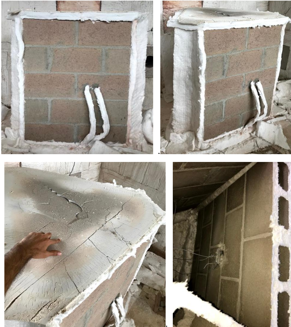
Figura C. 9 - Trio de pequenas paredes de 4,0 MPa e 140 mm após a simulação de incêndio
