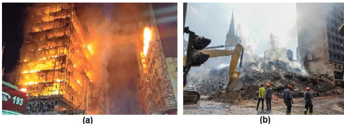
Figura 2.6 - Edifício Wilton Paz de Almeida em chamas (a); Escombros do edifício após o incêndio (b)
