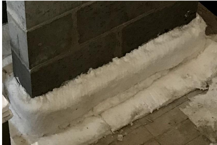
Figura 4.13 - Proteção térmica das bases de concreto com manta cerâmica
