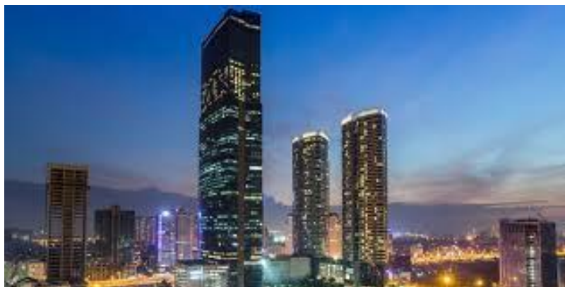
Figura 15 – Edifício Landmark 72, em Hanói, no Vietnã. Fonte: Landmark 72 (2019).
