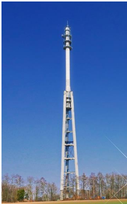
Figura 14 – Torre de Telecomunicação Namur, na Bélgica. Fonte: Rigot e Gaspart (1999).
