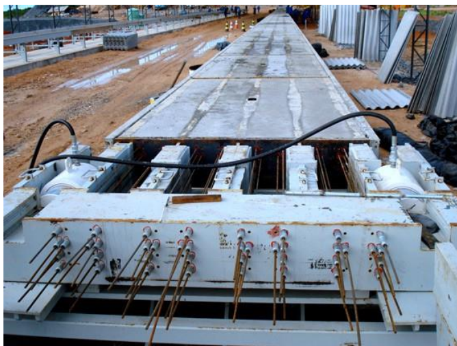
Figura 1 – Elemento pré-tracionado em pista de protensão. Fonte: Weiler (2019).
