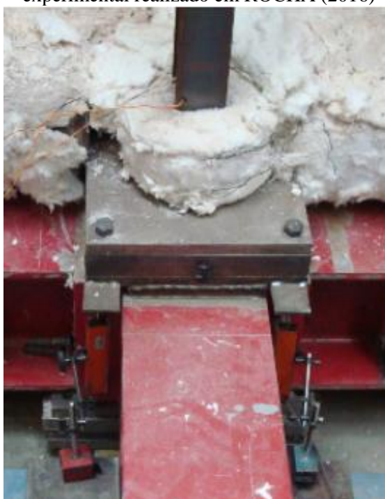
Figura 4.15- Posicionamento dos transdutores de deslocamento no topo do pilar no ensaio experimental realizado em ROCHA (2016)
