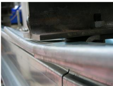
(c) Instabilidade distorcional da mesa comprimida da luva.
