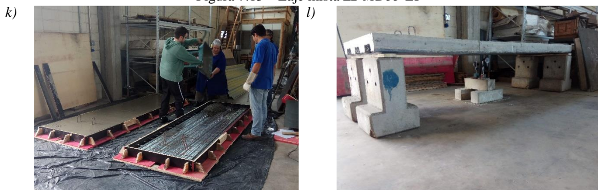
k) Concretagem lajes L2 (esquerda); l) Laje L2 sob peso próprio (2,40 kPa: 28-260 dias);
