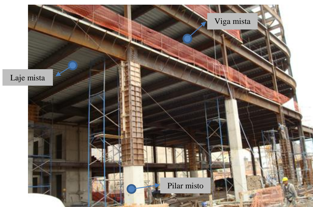
Figura 2.1 – Estrutura mista de aço e concreto
