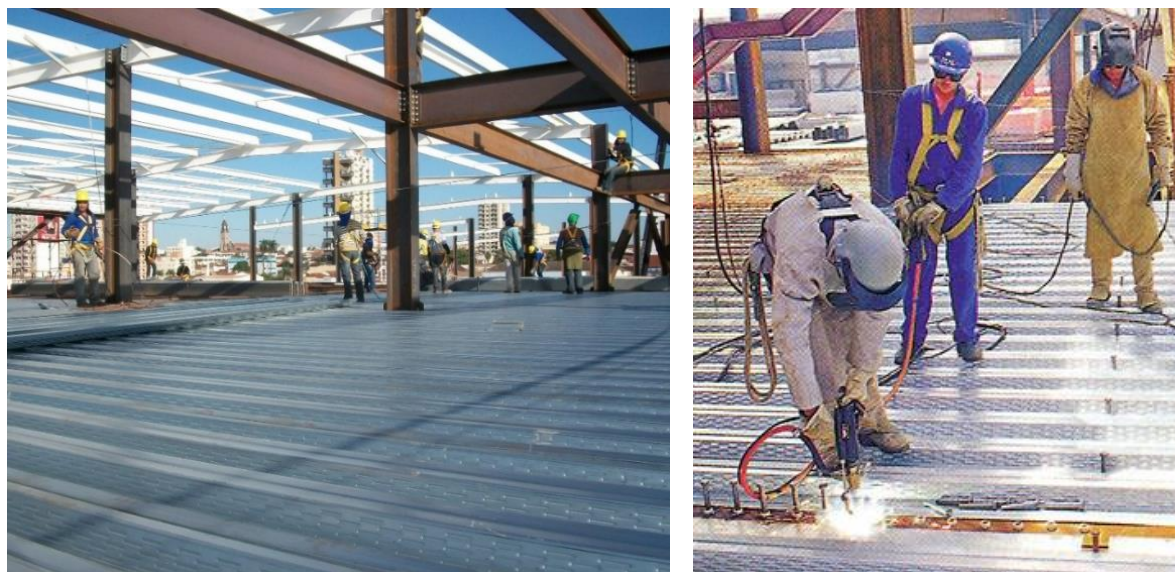
(a) Fôrma isolada como plataforma de trabalho
