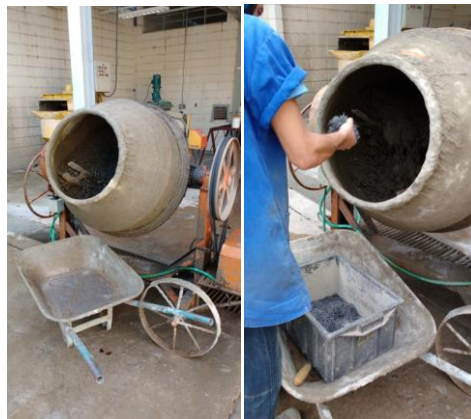
Figura 26-Mistura dos materiais na betoneira e inserção da fibra metálica no concreto
