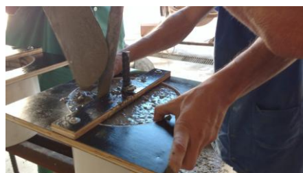
Figura 50-Controle da posição da armadura transversal durante a concretagem
