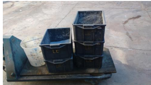
Figura 25-Separação dos materiais para concretagem
