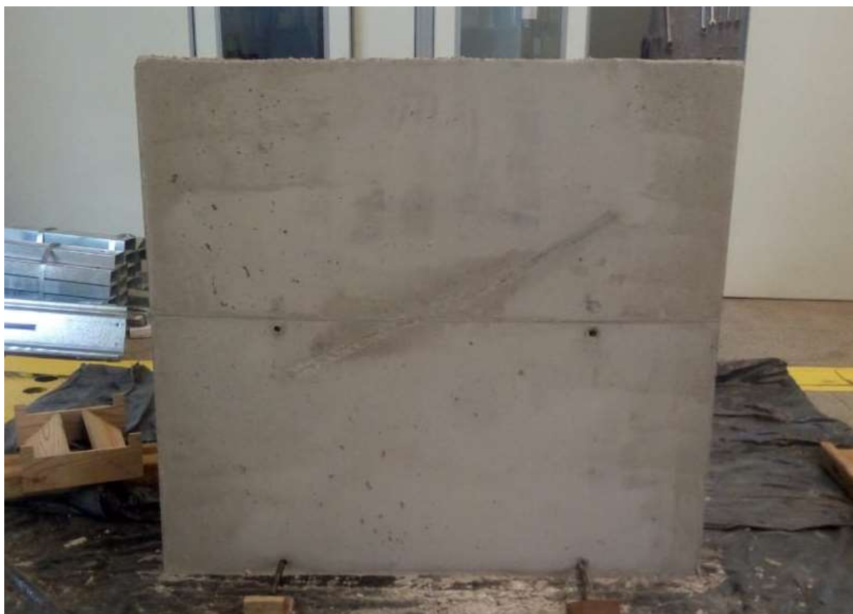
Figura 4.23 – C40 referência – Parede concretada.
