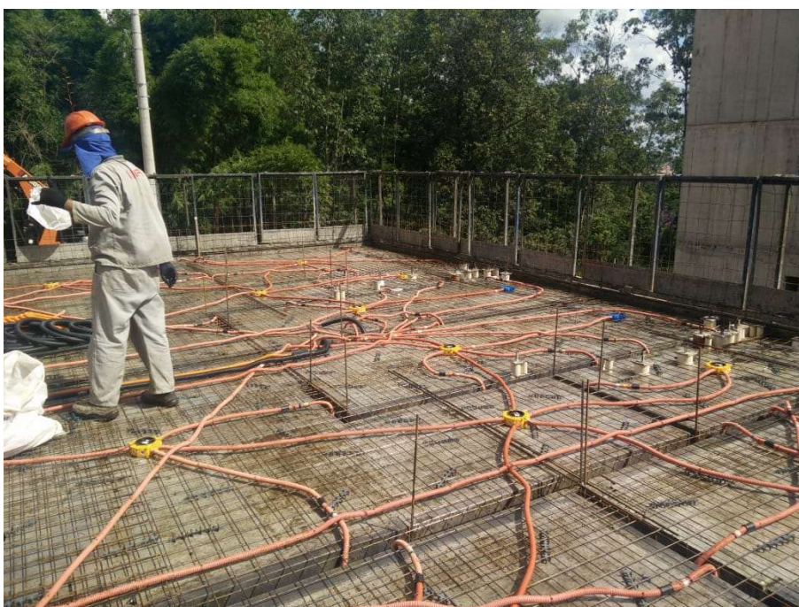
Figura 2.1 – Armação e posicionamento de instalações em lajes.
