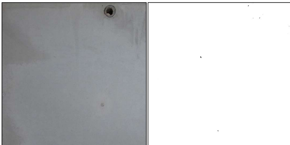
Figura 4.48 – Parede C40 15%, Quadrante 2, Face de Trás – Falha: 0,012%; Nota: 1,00.
