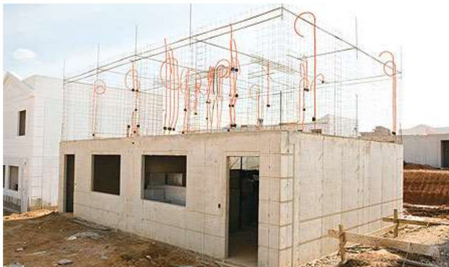
Figura 2.4 – Estrutura concretada e preparação para concretagem do próximo pavimento.
