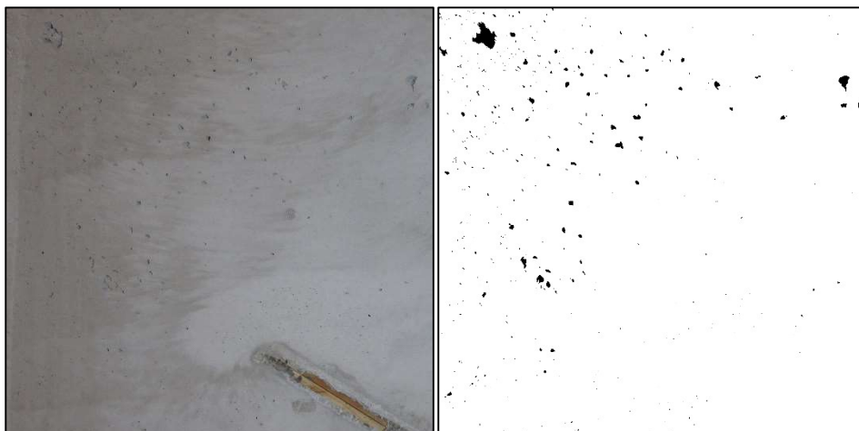
Figura 4.32 – Parede C40 referência, Quadrante 2, Face de Trás – Falha: 0,779%; Nota: 3,17.
