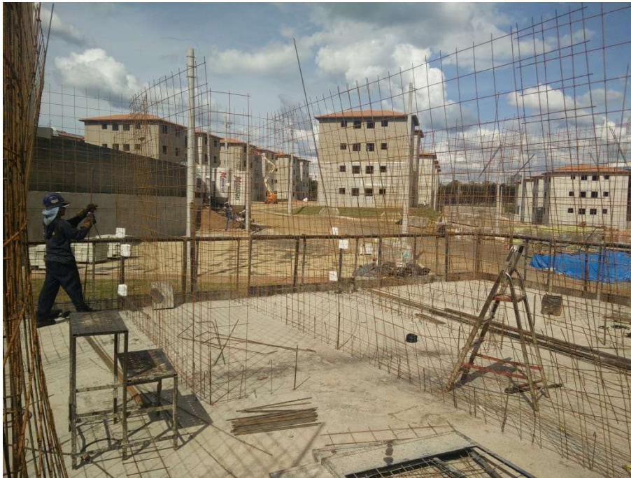
Figura 2.2 – Amarração de telas das paredes.
