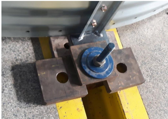
Figura 5.20 – Fixação do montante na laje de reação
