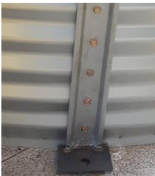
Figura 5.6 – Perfil de ligação montante-fundação
