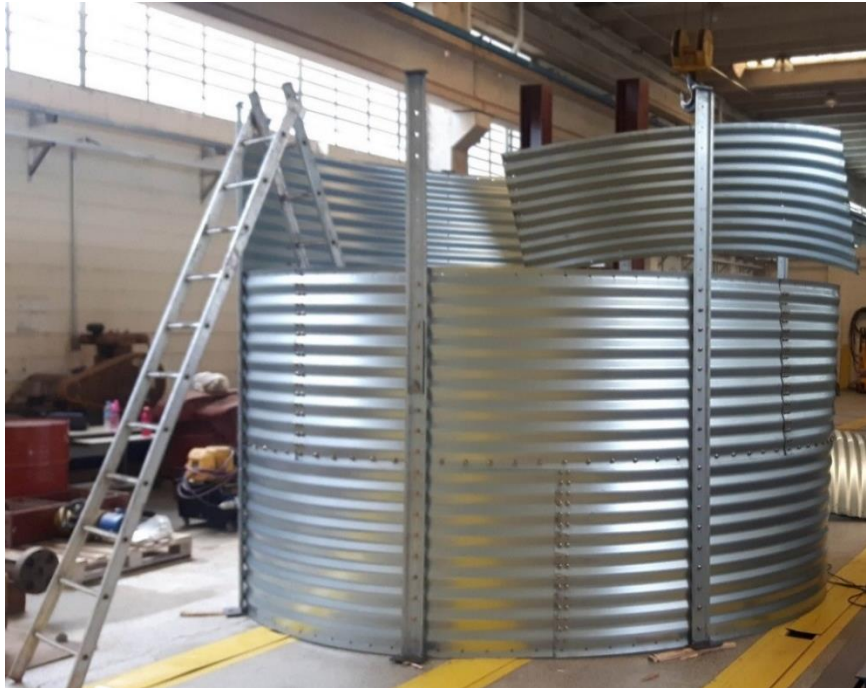
Figura 5.13 – Montagem Silo
