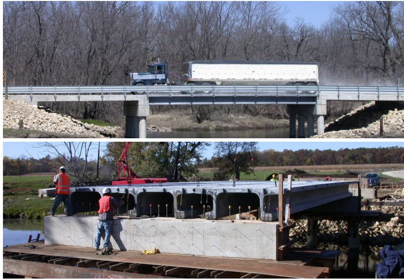
Figura 2.13 – Jakway Park Bridge (EUA): ponte rodoviária composta de vigas pré-moldadas de UHPFRC com 15 metros de comprimento (Fonte: www.ductal.com )
