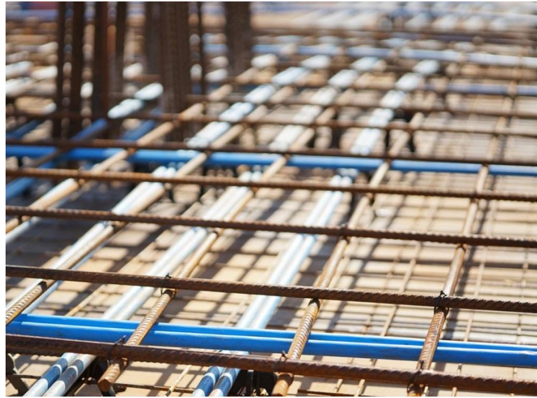
Figura 3. Armação de laje de concreto protendido.
