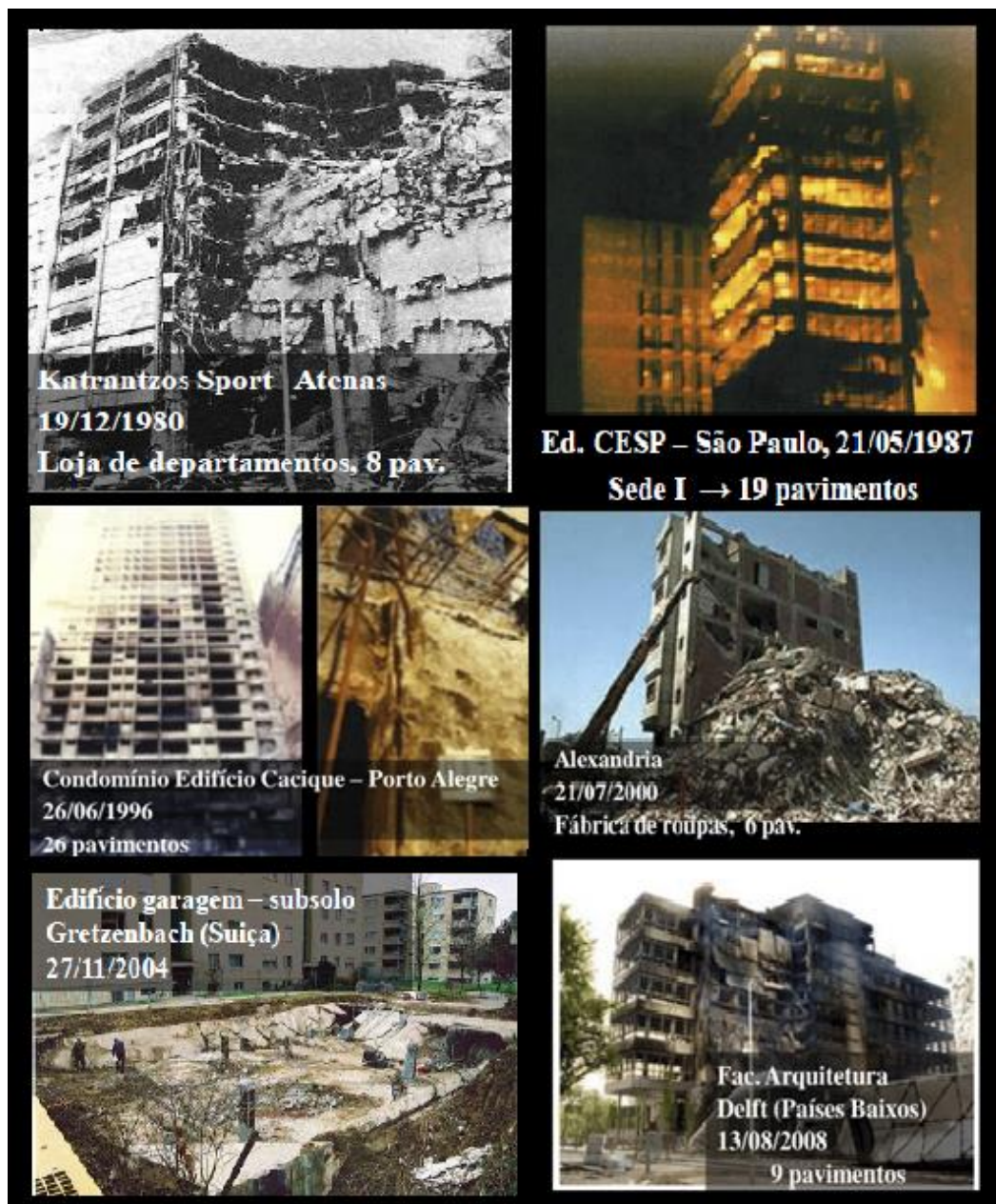
Figura 1 – Incêndios em edificações
