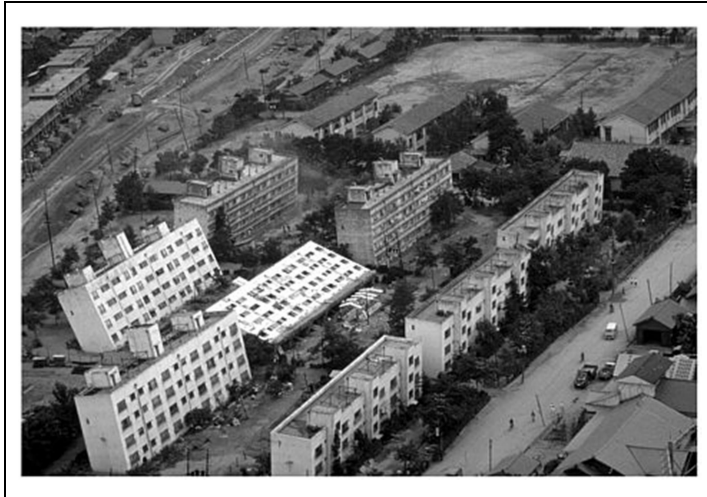
Figura 1.1 – Ruptura das fundações em Niigata, Japão, 1964.
