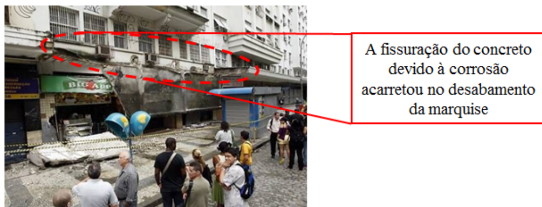
Figura 1.4 – Desabamento de Marquise no Rio de Janeiro em 2006.
