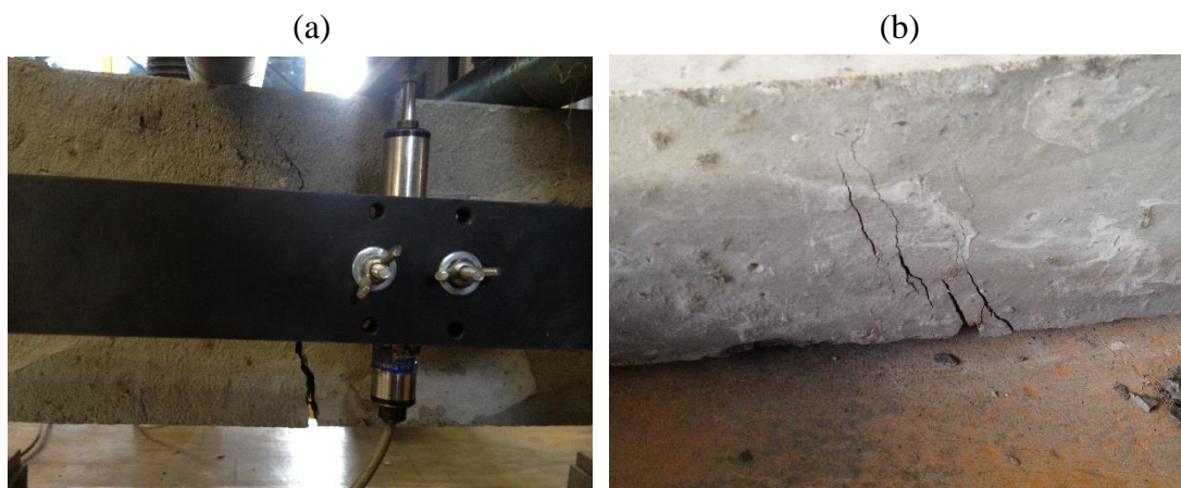
Figura 75 – Padrão de fissuração dos prismas com comportamento hardening (a) e formação de múltiplas fissuras em prisma de concreto CAR20FA
