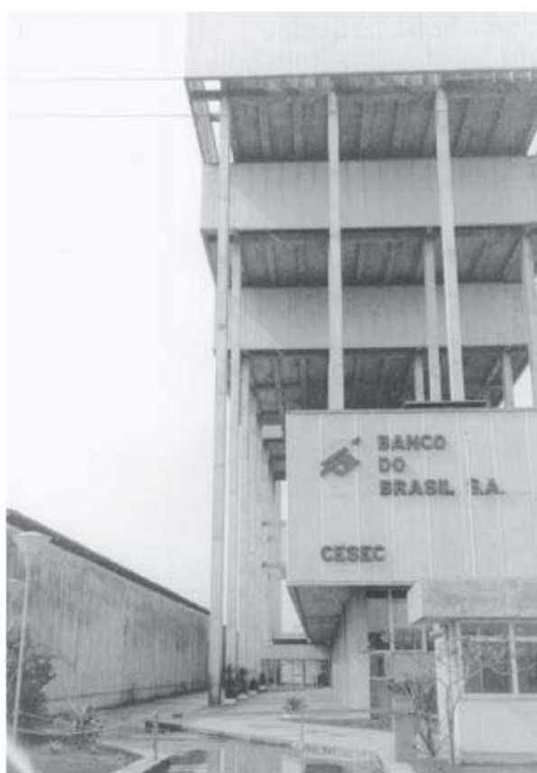
Figura 1.1 – Edifício com pilares esbeltos
