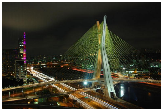
Figura 6 – Ponte sobre o Rio Pinheiros em São Paulo.
