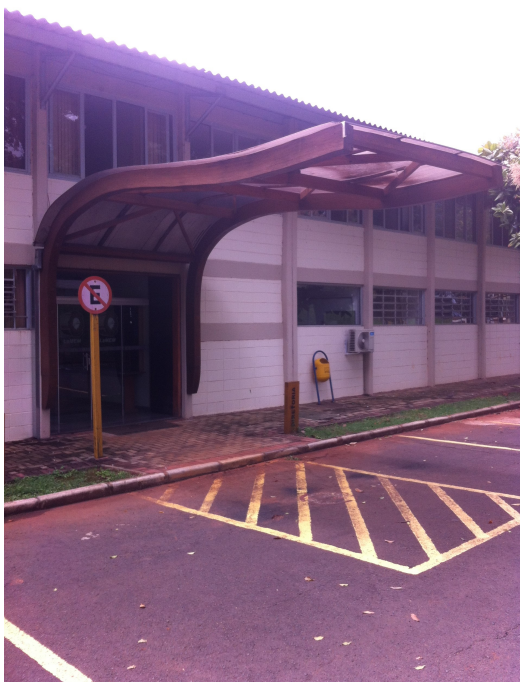
Figura 4.1 - Vista de uma cobertura com viga curva de LVL no laboratório de madeira e estruturas de madeira, Escola de Engenharia de São Carlos, Universidade de São Paulo
