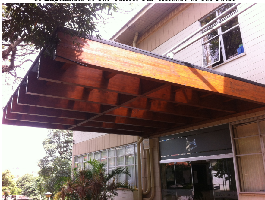
Figura 3.1 - Vista de uma grelha feita de MLC no Departamento de Engenharia de Estruturas, Escola de Engenharia de São Carlos, Universidade de São Paulo
