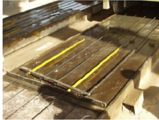
Figura 4.4 – Proteção das cordoalhas na aplicação do desmoldante.
