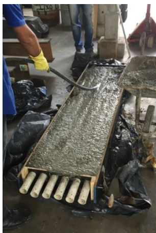
Figura 5.17 – Concretagem da laje
