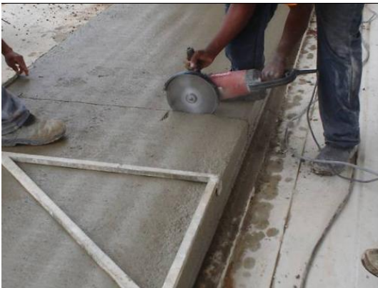
Figura 4.7 – Recorte no painel com concreto fresco.
