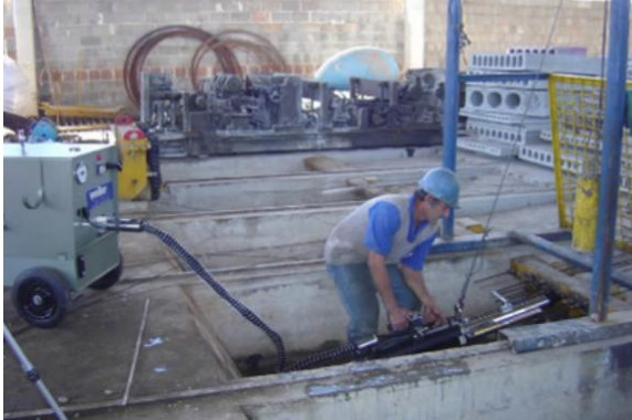
Figura 4.5 – Aplicação de protensão cabo a cabo.
