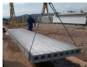
Figura 4.10 - Movimentação por meio de guindaste.
