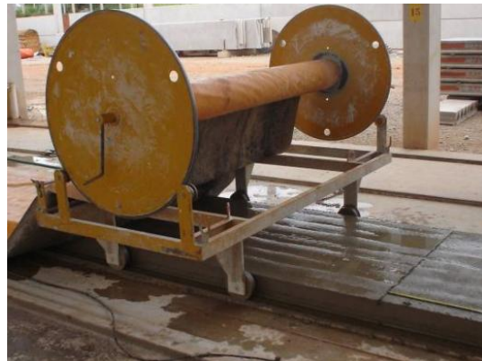
Figura 4.8 – Cura com lona térmica.
