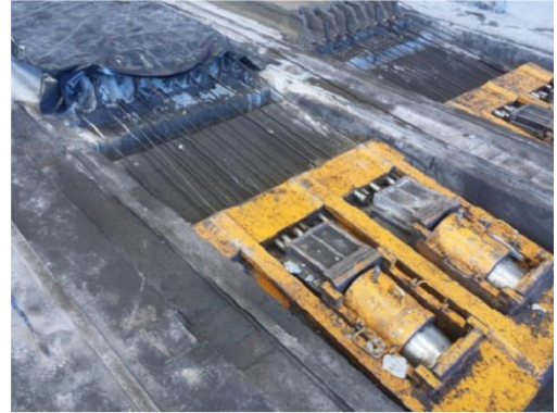
Figura 4.6 - Aplicação de protensão do conjunto de cabos.
