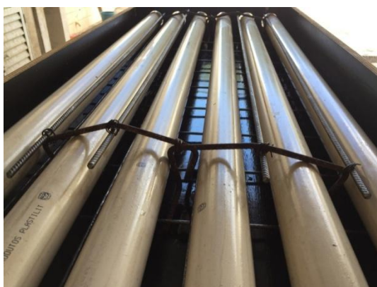
Figura 5.16 – Armação da laje
