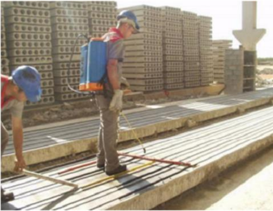
Figura 4.3 – Aplicação do desmoldante.
