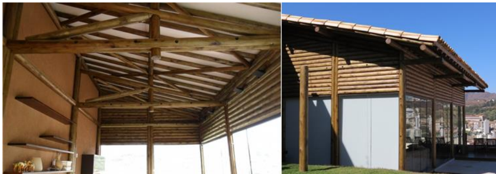
Figura 1 - Exemplos de utilização de perfis roliços na construção civil (AMARU)
