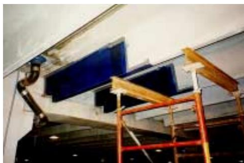
Figura 2.37 – Instalação de reforço com PRF nos dentes de concreto.
