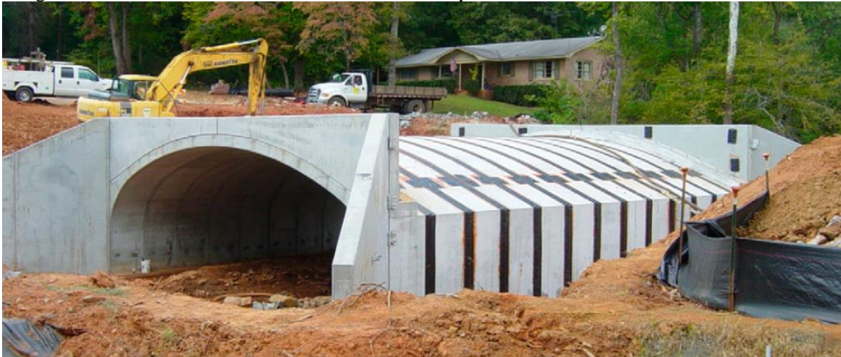
Figura 2.5 – Vão de 12,8 m de extensão em concreto pré-moldado em Midland, Carolina do Norte
