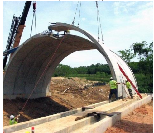
Figura 2.16 – Instalação de galeria aberta com seção em arco formada por dois segmentos
