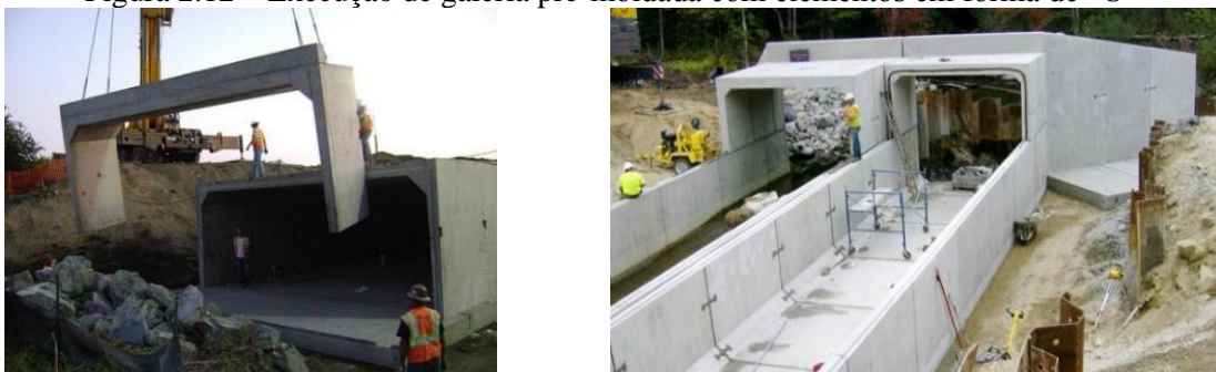
Figura 2.12 – Execução de galeria pré-moldada com elementos em forma de “U”
