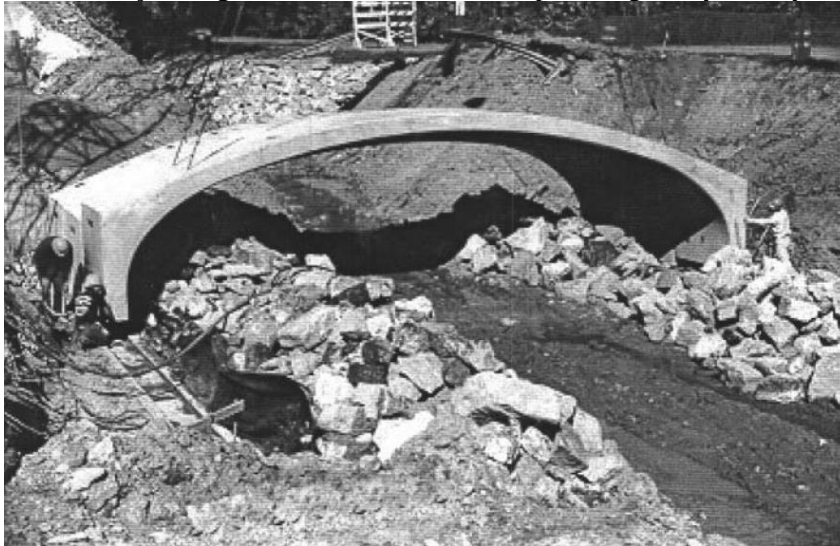
Figura 2.47 – Instalação da galeria em Miami Township, Montgomery Contry, Ohio, EUA.
