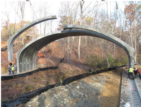
Figura 2.16 – Instalação de galeria aberta com seção em arco formada por dois segmentos
