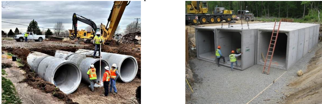
Figura 2.11 – Construção de galeria tripla com tubos de seção circular e célula retangular, respectivamente
