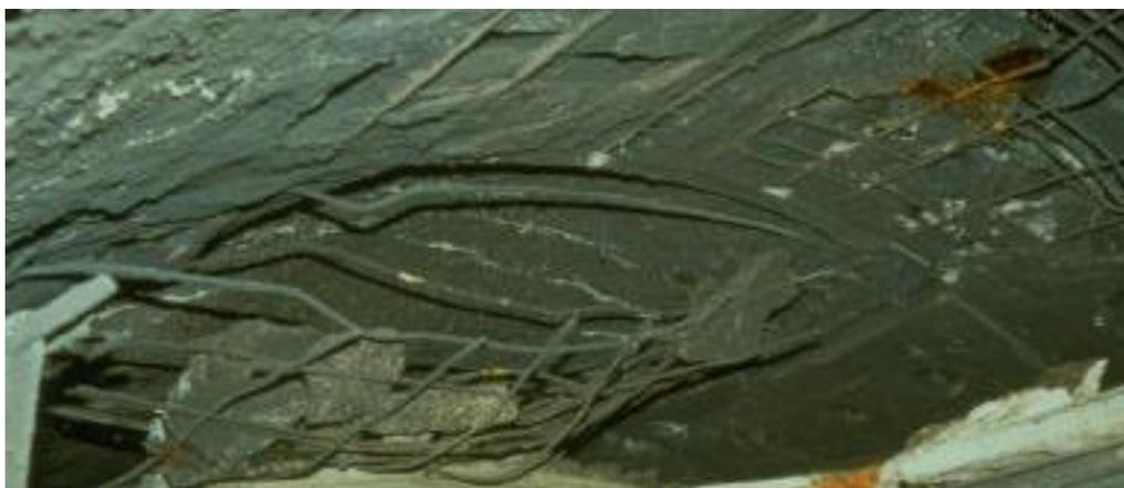
**Figura 3.25.** Armadura exposta após incêndio no Great Belt Tunnel, em 1994.
