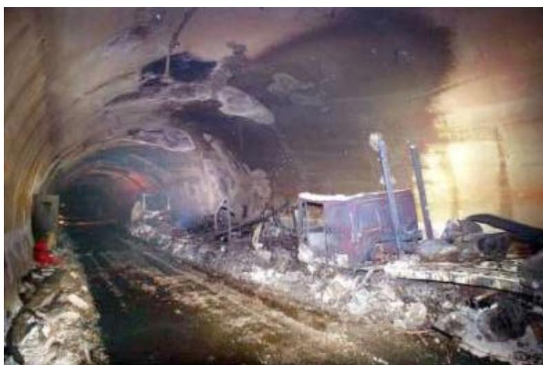
**Figura 3.27.** Situação de lascamento após incêndio no Mont Blanc Tunnel, em 1999.
