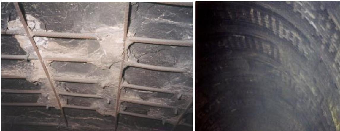
**Figura 3.26.** Armadura exposta após incêndio no Channel Tunnel, em 1996.
