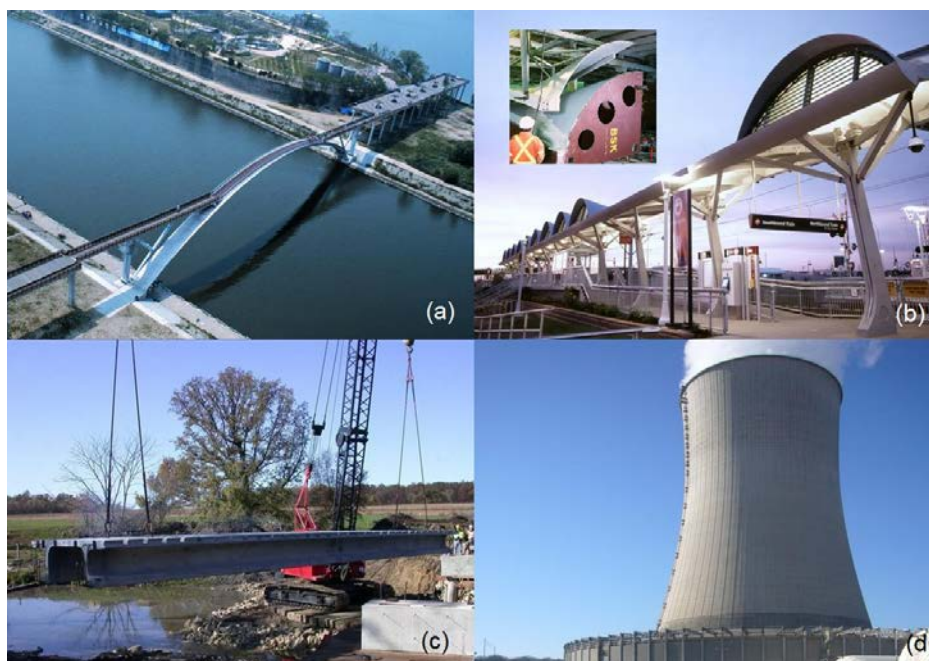
Figura 2.2 – Obras internacionais que utilizaram UHPFRC: (a) Passarela Seonyu, Seul, Coréia; (b) A Estação de Metro Shawnessy, Calgary, Canadá; (c) Ponte do Parque Jakway, Iowa USA; (d) Vigas e longarinas na estação de energia elétrica de Cattenom, Iowa, EUA Fonte: Ductal (2014)
