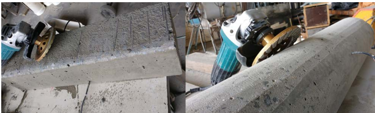
Figura 3.21 – Preparo da superfície para receber o UHPC e o UHPFRC
