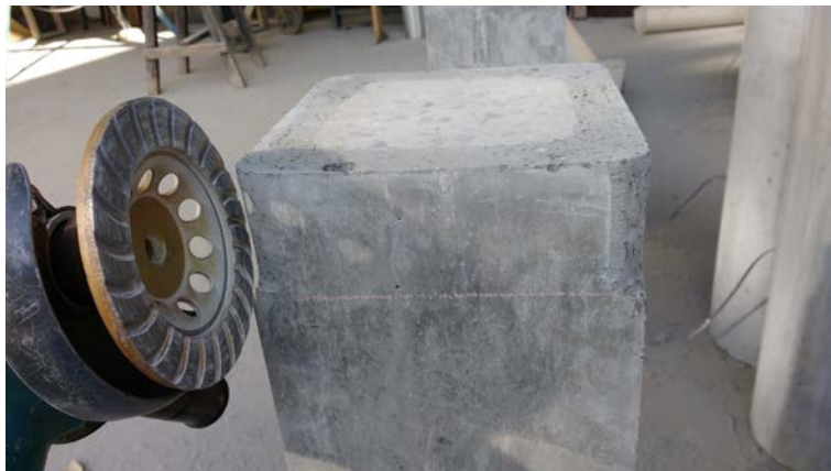
Figura 3.25 – Arredondamento dos cantos dos pilares quadrados com esmerilhadeira para receber o PRFC
