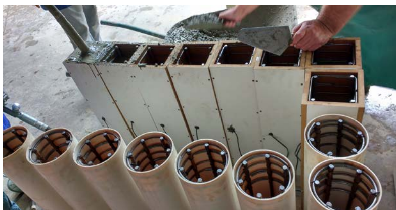
Figura 3.20 – Concretagem dos pilares com concreto convencional
