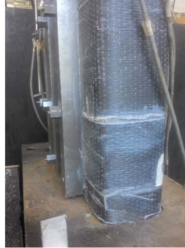
(b) Ruptura do tirante na extremidade inferior e fissura horizontal indicando esmagamento na região sem PRF
