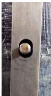
Figura 4.14 - Folga entre perfil de aço e tirante proporcionada pelo furo em falsa elipse
