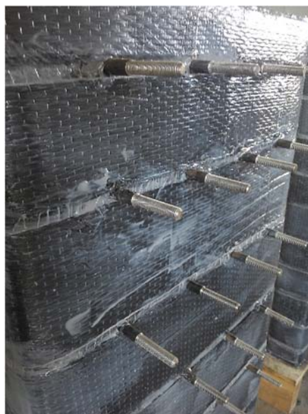
(b) Detalhe das faixas sem PRF devido à presença dos tirantes
