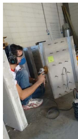
(b) Lixamento da superfície junto aos cantos
