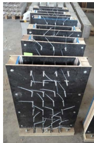
(b) Fôrmas construídas e os tirantes já posicionados fixados com abraçadeiras elásticas
