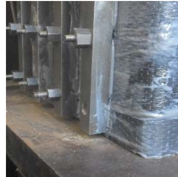
(c) Ruptura do tirante na extremidade inferior
