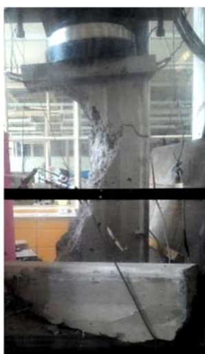
Figura 3.41 - Ruína do pilar P1
