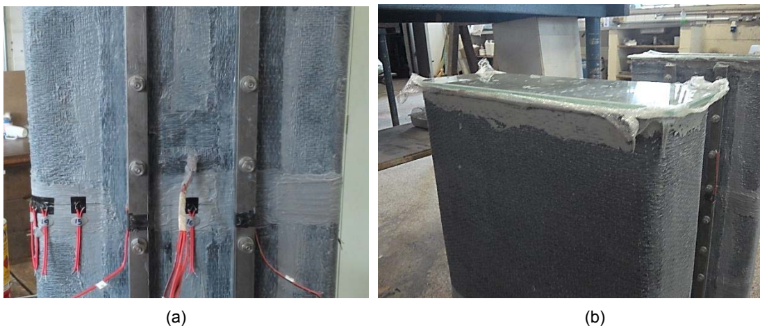
Figura 3.33 - (a) Encamisamento do pilar P3; (b) Retificação da extremidade dos pilares.
