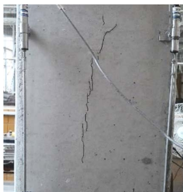
Figura 4.36 - Fissura vertical durante ensaio do Pilar P4-0-0-0-0b
