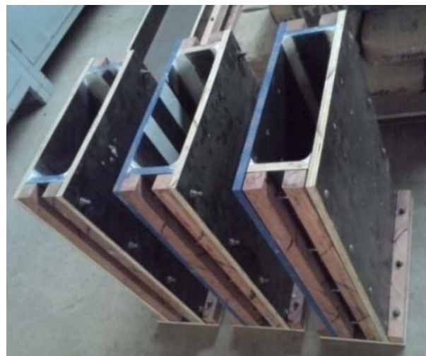
Figura 3.29 - Fôrmas dos pilares (a) dimensões (b) fôrmas acabadas
