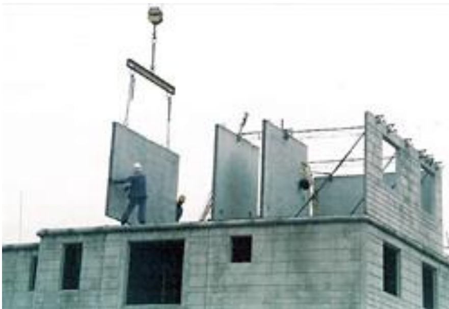
Figura 2.17 – Montagem de edifício com paredes de concreto pré-moldado. [Fonte: http://www.pedreiradefreitas.com.br , acesso em: 28/02/2013]
