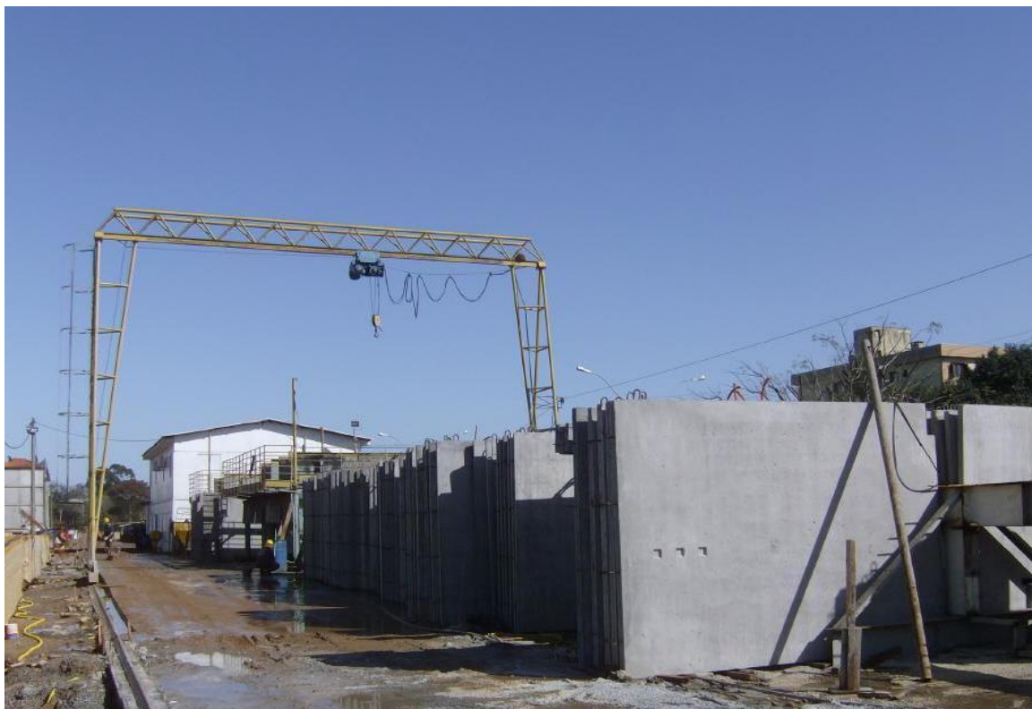
Figura 2.6 – Pórtico rolante utilizado para o transporte dos painéis portantes. [Fonte: http://www.ufrgs.br/eso/content/?tag=paineis-portantes , acesso em 04/02/2013]
