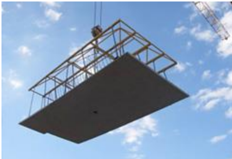
Figura 2.14 – Laje pré-moldada suspensa por balancins. [Fonte: http://pedreira.eng.br/index.php?option=com_content&view=article&id=58&Itemid=91 , acesso em 22/02/2013]
