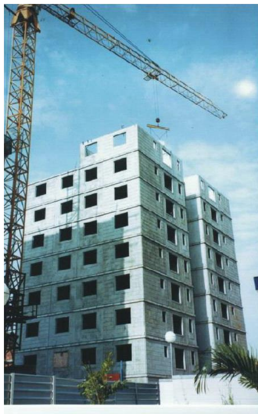
Figura 1.1 – Edifício com paredes de concreto pré-moldado e lajes pré-moldadas.
