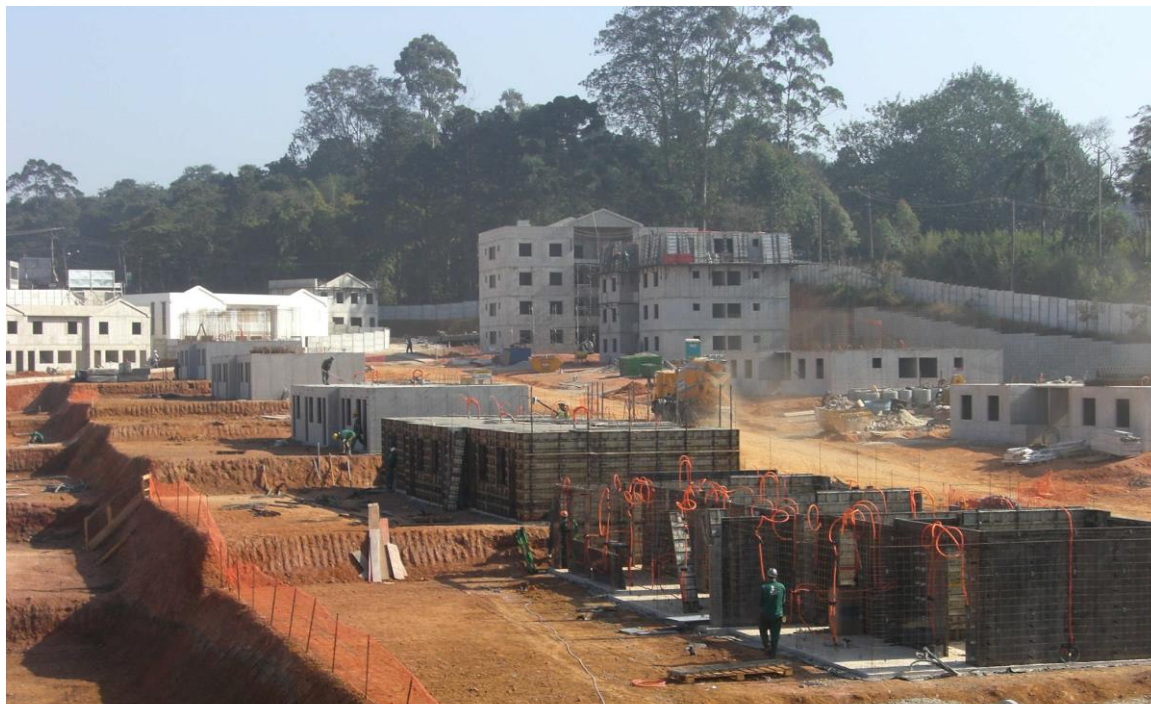
Figura 2.16 – Construção de edifícios de concreto com alta repetitividade.
