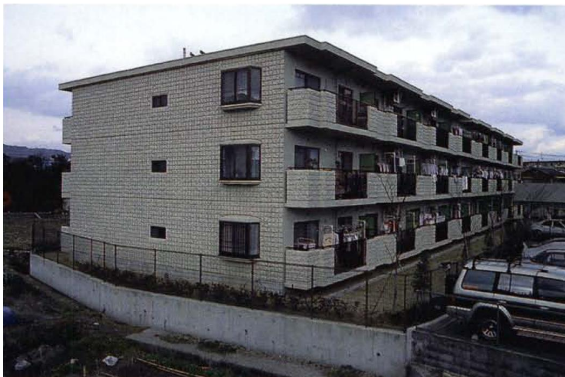
Figura 2.19 – Edifício de paredes pré-moldadas que apresentou bom desempenho após o terremoto de Kobe no Japão. [Fonte: Ghosh (1995)]
