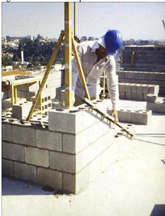
Figura 16 – Escantilhão para nivelamento das fiadas
