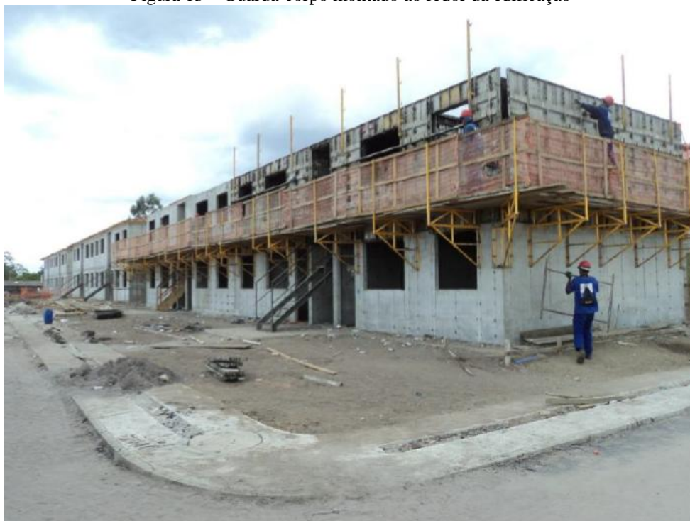
Figura 13 – Guarda-corpo montado ao redor da edificação
