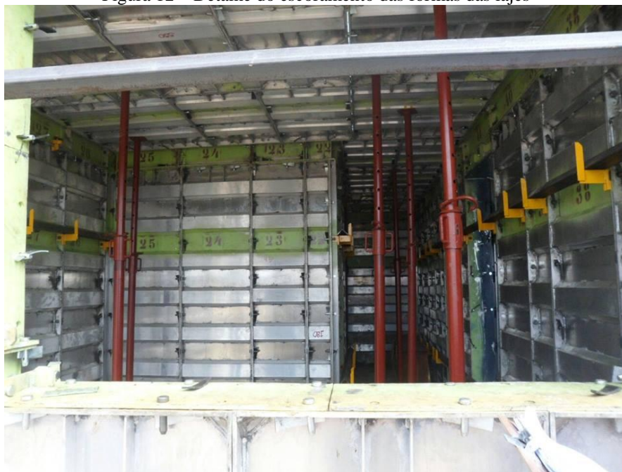
Figura 12 – Detalhe do escoramento das fôrmas das lajes
