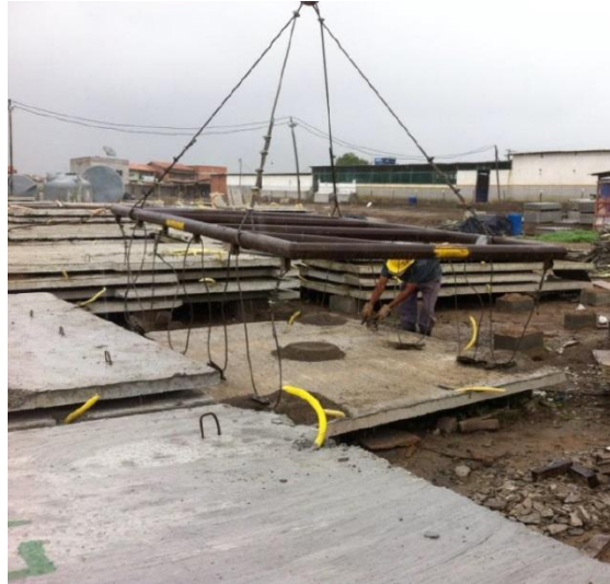
Figura 14 – Laje pré-moldada sendo preparada para o içamento
