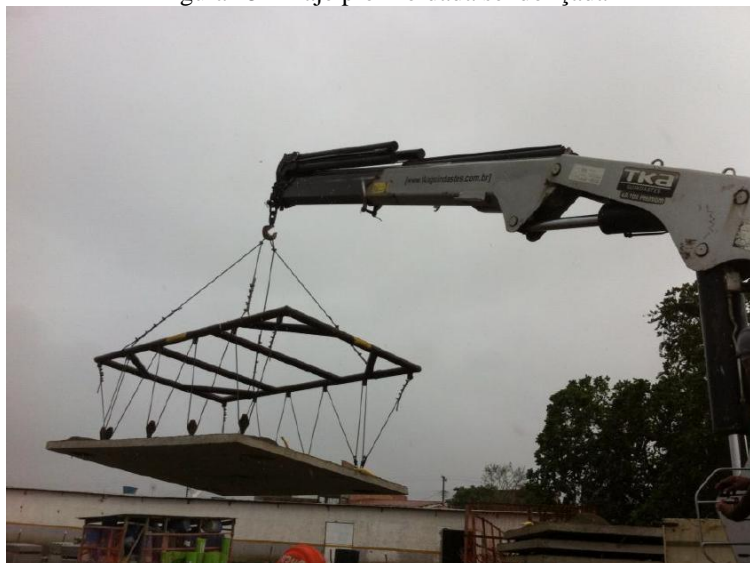
Figura 15 – Laje pré-moldada sendo içada
