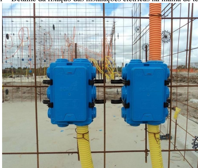
Figura 11 – Detalhe da fixação das instalações elétricas na malha de tela soldada
